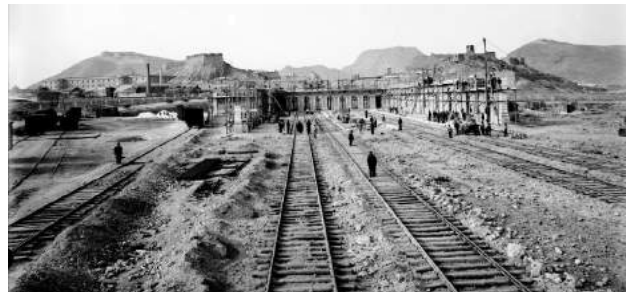
Fig. 64. Labores de finalización en el muro de cierre norte, construcción del andén central y panorámica de las vías de la estación definitiva de viajeros junto a las de los muelles de mercancías, AHF-FM. Salgado Lancha, J. (fotógrafo). Estación de Cartagena. 8 de febrero de 1906. 1 fotografía - Negativo [Vidrio]: bl. y n.; 2739 / 3425 mm. Fondo / Colección: MZA - Servicio Vía y Obras. Signatura: MZA- 3432-IF_8-12.
