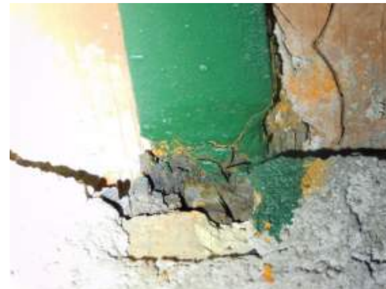
Detalle de laminación de vigueta en forjado de cubierta central.
