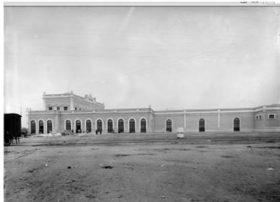
Fig. 72. Vista del sur de la estación de Cartagena con el pabellón de retretes en el extremo derecho, separado del resto de estancias del servicio, AHF-FM. Salgado Lancha, J. (fotógrafo). Estación de Cartagena. 1906-1907. Fotografía - Negativo [Vidrio]: bl. y n.; 2737 / 3425 mm. Fondo / Colección: MZA - Servicio Vía y Obras. Signatura: MZA- 3440-IF_8-12.
