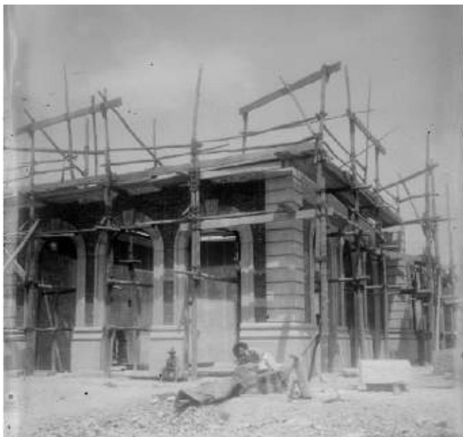
Fig. 48. Instalación de la placa de hormigón armado en el pabellón angular norte de la estación de Cartagena. AHF-MFM. (Salgado Lancha, J. -fotógrafo-). ca. 1906. Estación de Cartagena. Fotografía - Negativo [Vidrio]: bl. y n.; 3425 / 2755 mm. Fondo/Colección MZA - Servicio Vía y Obras. Signatura: MZA-3435-IF_8-12.
