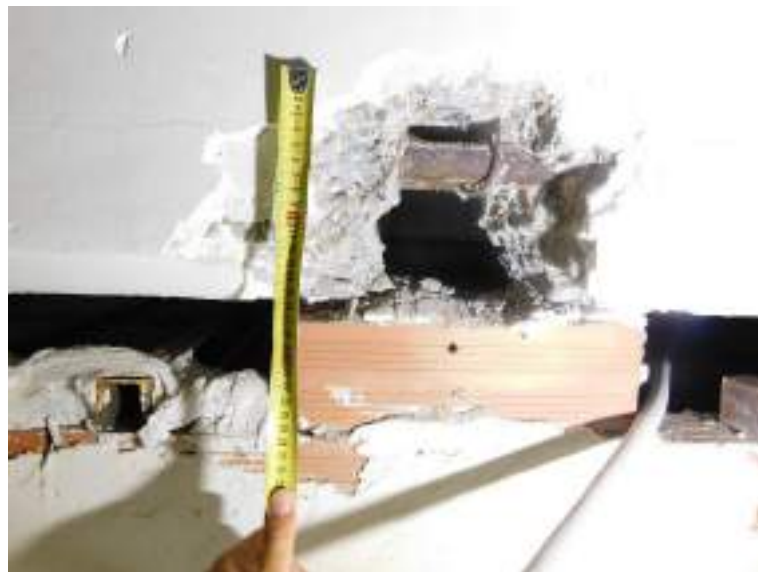
Cata en centro de vano de viga de cubierta en cuerpo sur.
