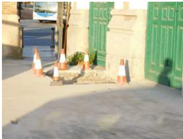
Localización de calicata en esquina suroeste.
