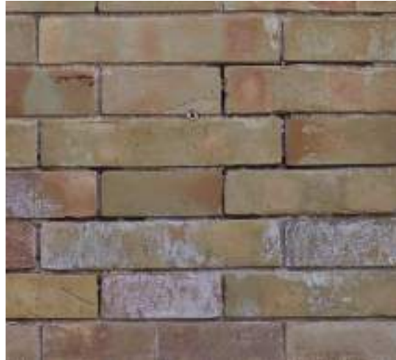
▲ Eflorescencias salinas en la fábrica de ladrillo, coincidiendo con una zona con rejuntado de cemento.
