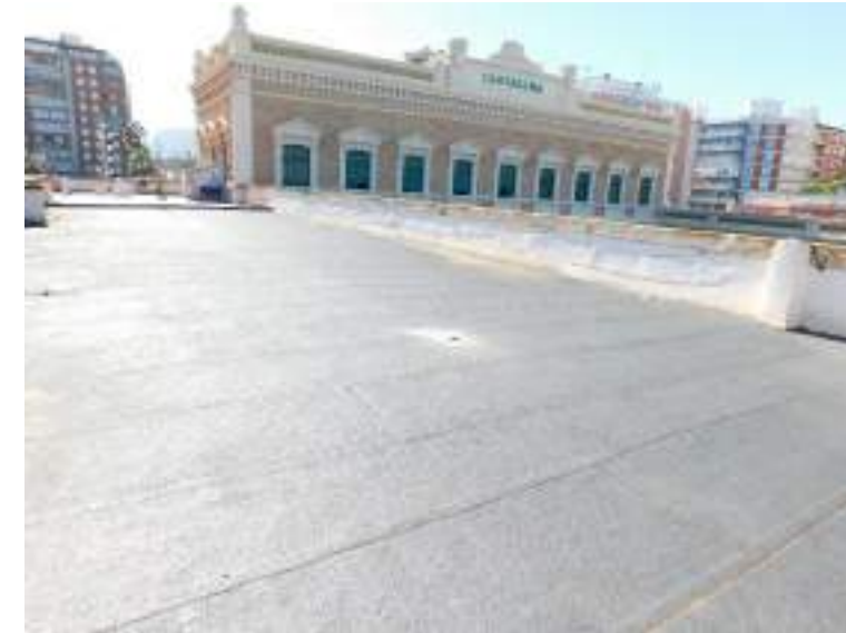
Localización de cata en cubierta Sureste.
