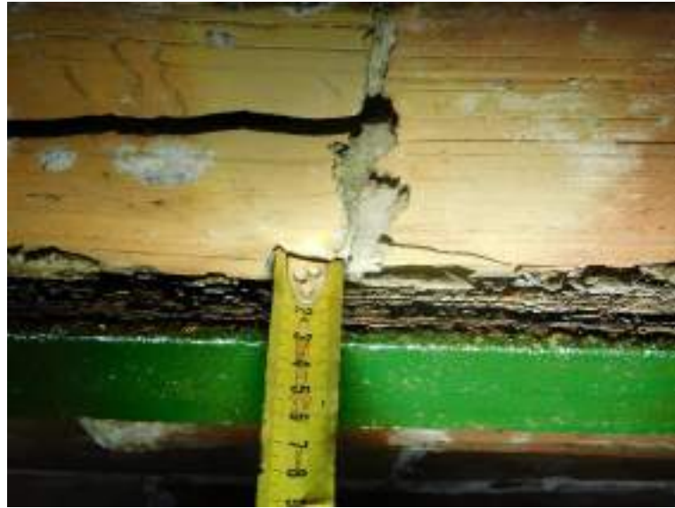
Detalle de laminación de ala inferior de vigueta en cubierta central.
