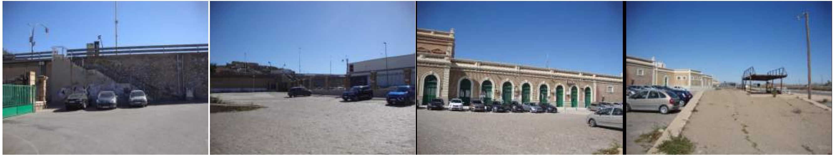
Aparcamiento exterior y acceso peatonal carretera
