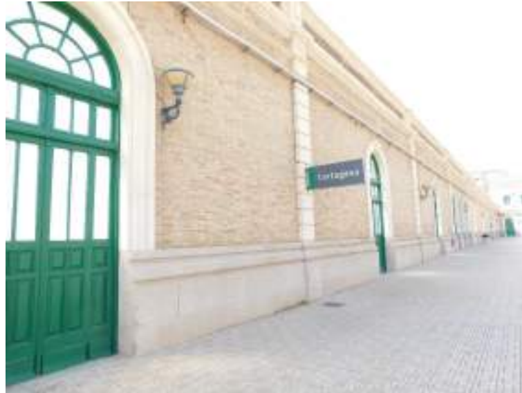
Muro exento junto al andén sur. Vista fugada interior.
