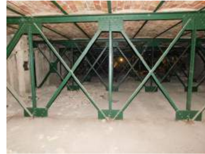
Cerchas en aparente buen estado de conservación.
