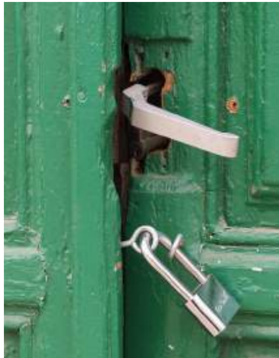
▲ Detalle de una carpintería que no conserva los herrajes originales.
