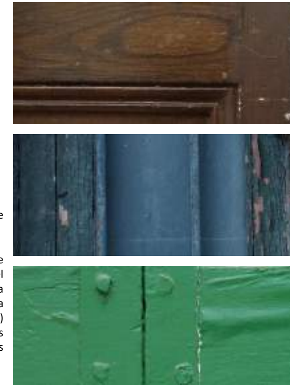
▲ Estratigrafía de los revestimientos de las carpinterías de madera obtenida de la muestra PM tomada "in situ".
