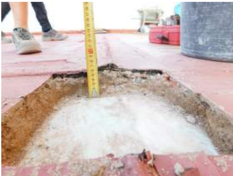
Detalle de cata en cumbrera de cubierta noroeste.
