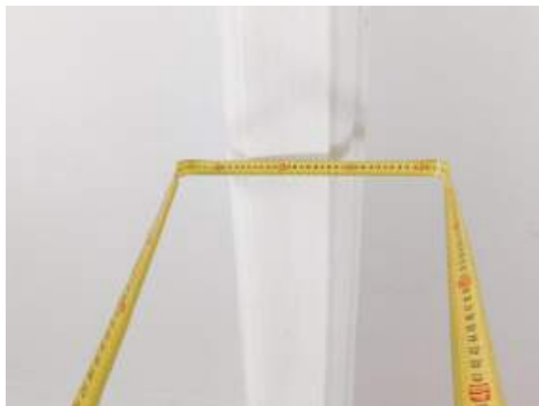
Ancho de la viga de descuelgue. Nave norte.
