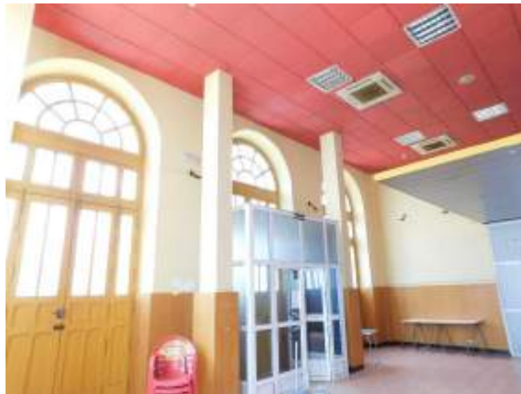
Pilares en la cafetería de la esquina suroeste. Vista general.
