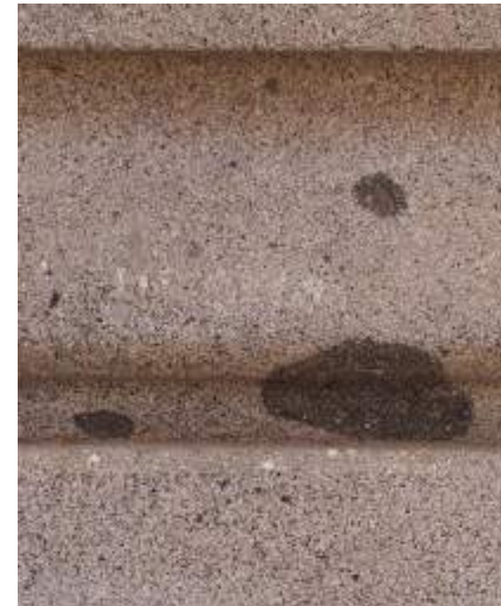
◀ Detalle de gabarras en la piedra de granito natural.
