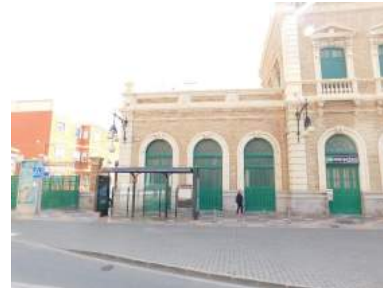
Fachada oeste de la nave norte.
