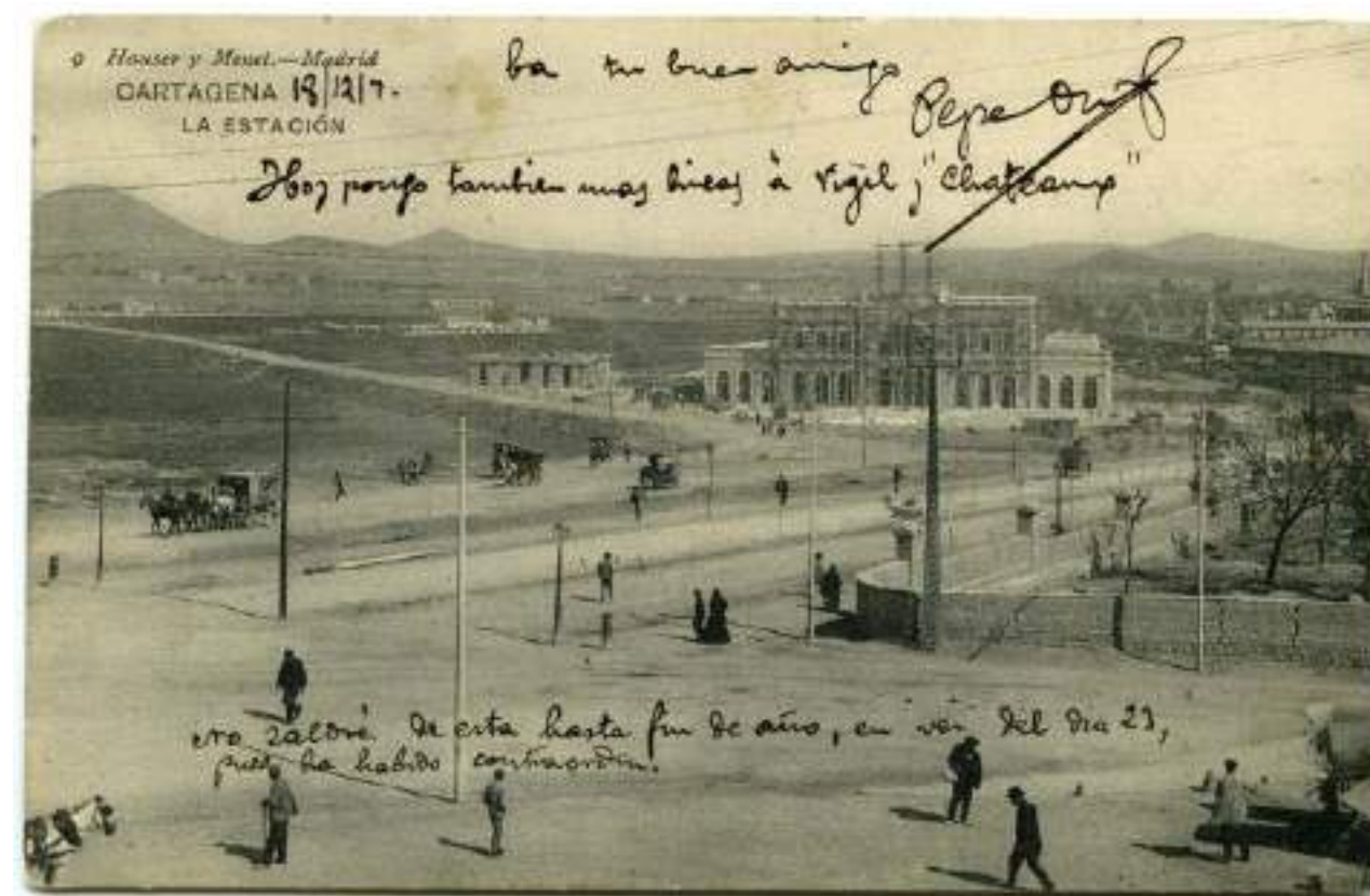
Fig. 85. La estación definitiva de Cartagena a pocas semanas de su finalización completa en diciembre de 1907. AGRM. Hauser y Menet (Madrid). La estación de Cartagena . 1907. Tarjeta postal - Papel: bl. y n.; 77 x 109 mm; presentación: 312 x 246. Archivo General de la Región de Murcia. Fondo/ Colección: Colección de tarjetas postales y otro material gráfico referido a la Región de Murcia (1843-1996). Signatura: FOT_POS,009/048.
