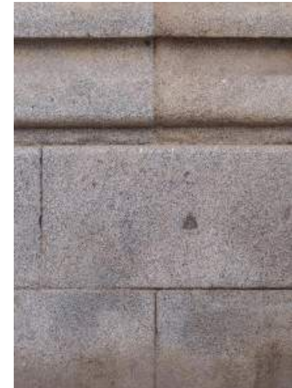
▲ Aspecto macroscópico de la piedra de granito de Don Benito del edificio de viajeros.
