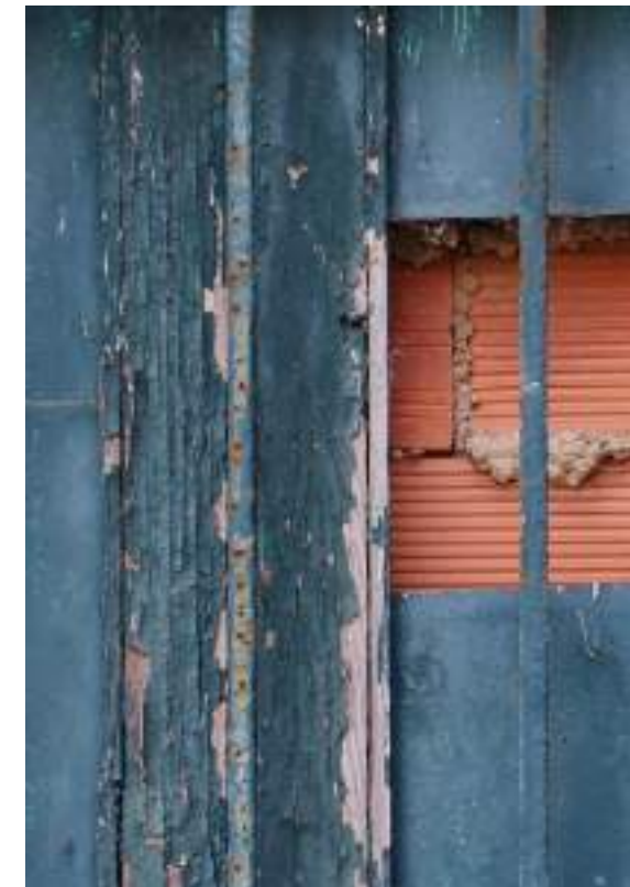
▲ Aspecto irregular de una carpintería por la falta de preparación de la superficie antes de ser pintada.
