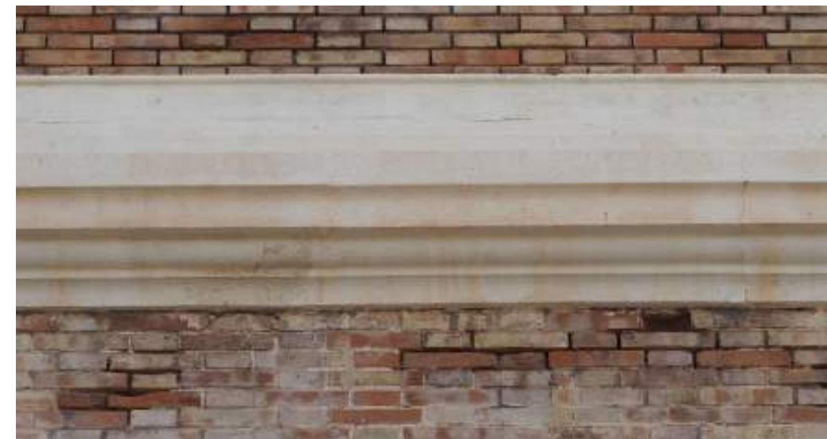
▲ Importante grieta de recorrido escalonado en uno de los paños de fachada.
