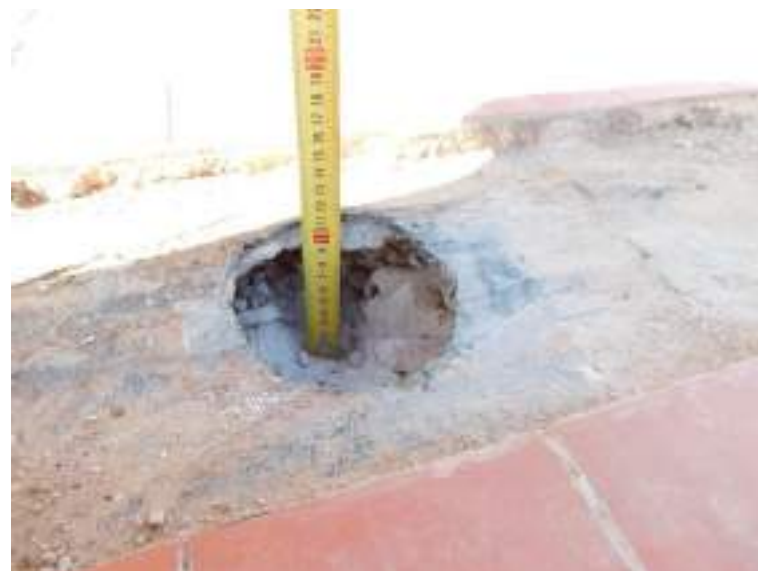
Detalle de cata en cubierta suroeste.
