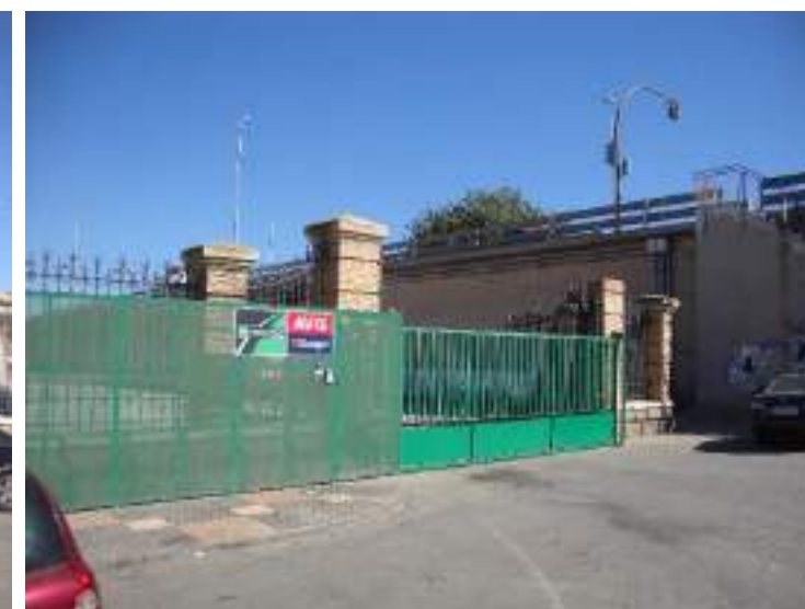
Portón de acceso a aparcamiento zona Sur
