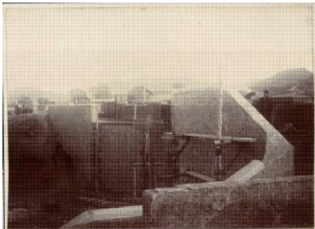
Fondo / Colección: M.Z.A. - Servicio Vía y Obras. Signatura: F- 0191- Volumen: 1 Fotografía (s) - Positivo [Papel] : bl. y n. ; 77 x 108 mm ; presentación: 312 x 246 Fecha: 31/01/1902 Título: Estación definitiva de Cartagena en la línea de Albacete a Cartagena durante su construcción Descripción: Perspectiva parcial de un paso superior en construcción de la estación. En segundo plano a la derecha, aparece una figura bien vestida y con bombín, que corresponderá seguramente al ingeniero encargado de las obras. A la izquierda, en segundo plano y al fondo, se puede observar a personal de obras trabajando. Al fondo a la derecha, se puede vislumbrar un carro de caballos. ALICANTE (M.Z.A.) (1856-1941) GEOGRÁFICO: 1. CARTAGENA (MURCIA) Notas: Montada sobre cartulina junto a otras cinco fotografías sobre el mismo tema.
