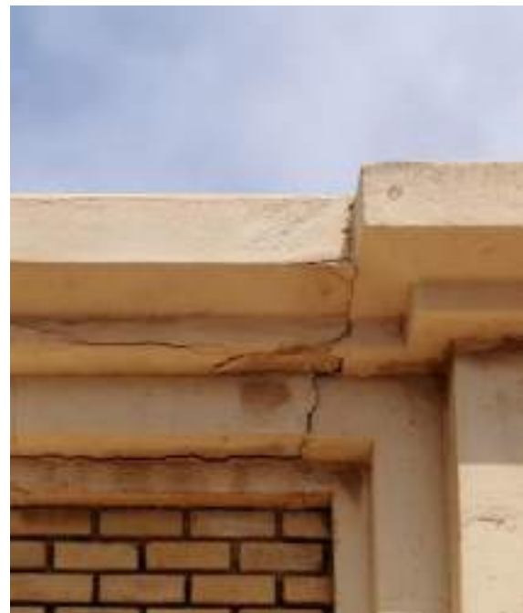
▲ Zonas de desprendimiento del mortero de cemento superficial relacionado con zonas grietas, dejando a la vista el mortero interior.
