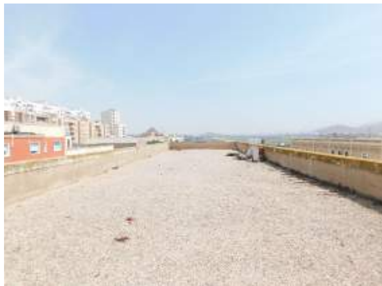
Vista general de la cubierta de la nave norte. Tramo paralelo a vías.
