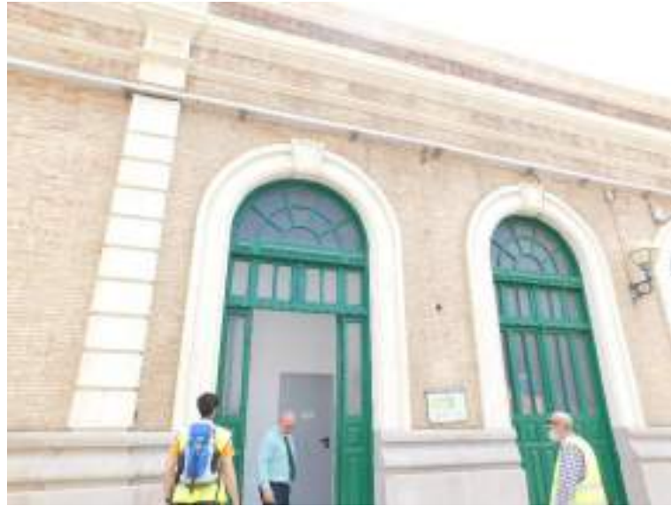
Fachada norte del edificio de trabajadores.
