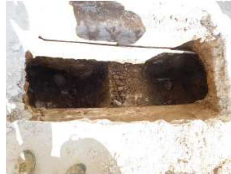
Calicata en esquina suroeste de cuerpo central.
