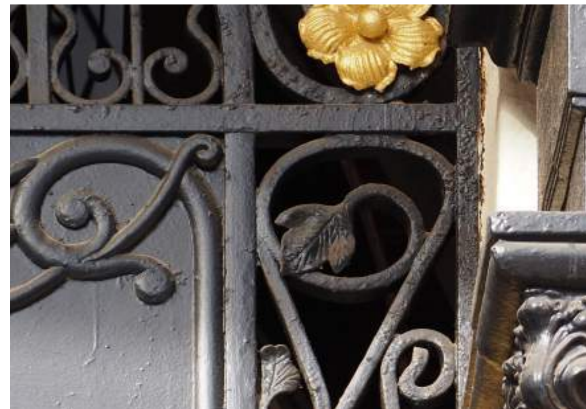
Imagen de una zona de la rejería donde es muy evidente la rugosidad de la superficie bajo la pintura.
