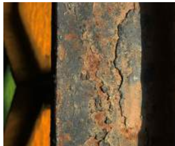
▲ Detalle de la rotura de una de las piezas de la vidriera.
