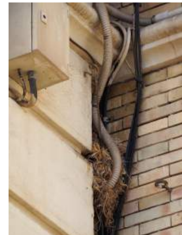
▲ Detalle una planta superior que se ha desarrollado en la junta entre dos paños de la fábrica de ladrillo.
