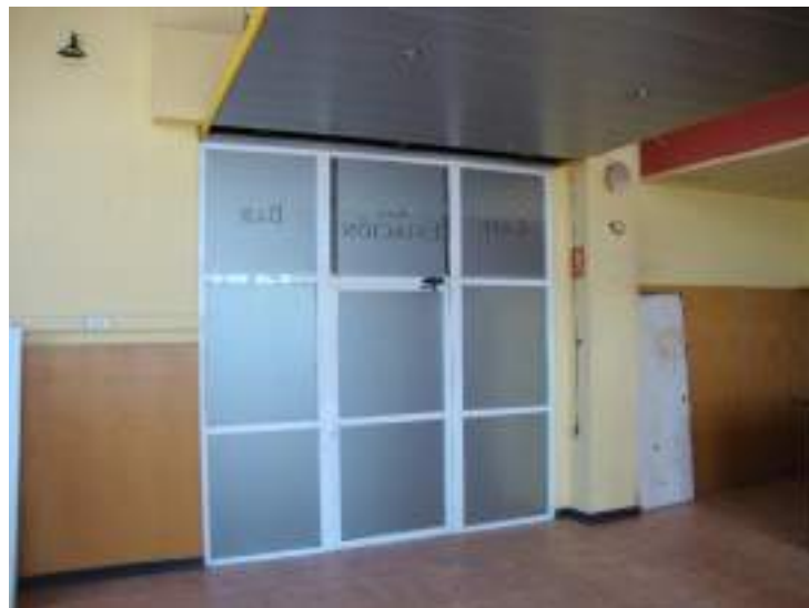
Acceso desde vestíbulo
