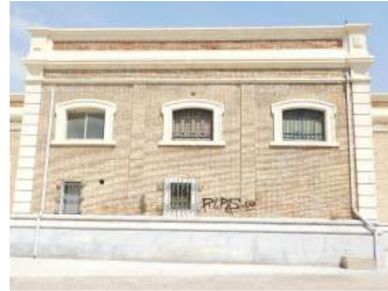
Fachada sur del edificio de trabajadores.
