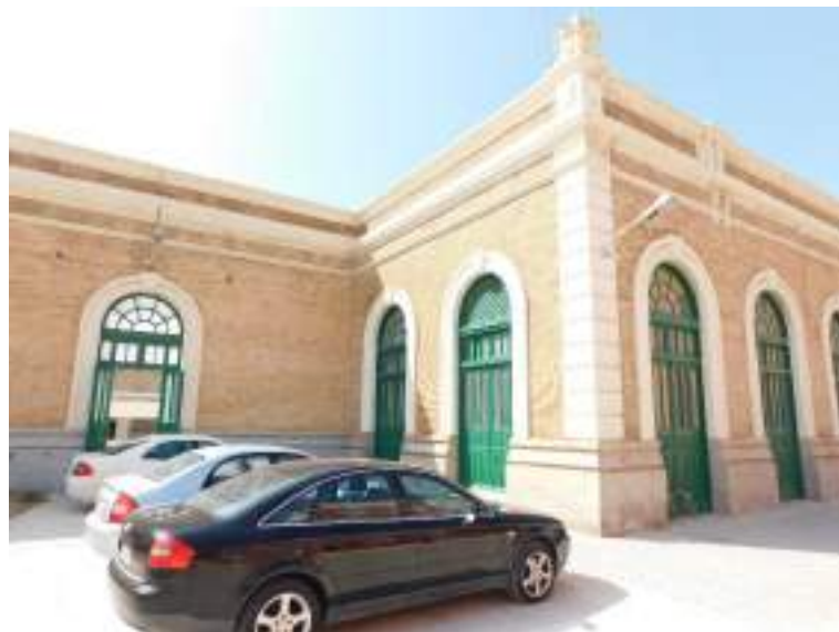
Fachada este de la nave norte.
