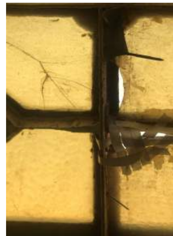
▲ Detalle de una pieza de vidrio sustituida por otra de vidrio simple coloreado, dejando restos de la masilla empleada para la instalación de la pieza.
