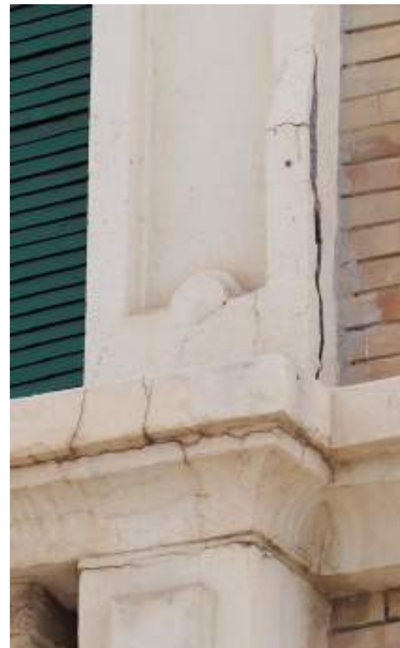
▲ Zonas de desprendimiento del mortero de cemento superficial relacionado con zonas grietas, dejando a la vista el mortero interior.
