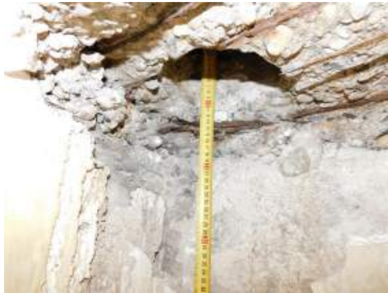
Detalle de cata en cubierta sureste.
