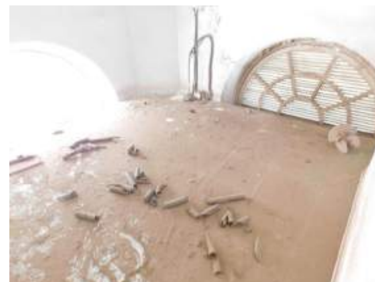
Forjado nuevo en nave norte. Vista superior.
