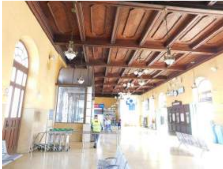
Forjado de planta primera. Vista inferior del forjado de planta primera.
