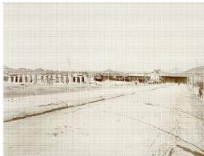
Fondo / Colección: M.Z.A. - Servicio Vía y Obras. Signatura: F- 0092- Copias: Diapositiva Volumen: 1 Fotografía (s) - Positivo [Papel] : Sepia ; 236 x 297 mm ; presentación: 340 x 415 mm Fecha: 09/02/1906 Autor: SALGADO LANCHA , JUAN (FOTÓGRAFO) Título: Estación de Cartagena Descripción: Perspectiva general Página de la 1 situación de las obras en la estación definitiva de Cartagena.
