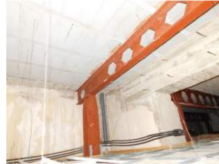
Nuevo forjado de cubierta. Pilares, vigas alveoladas y forjado de viguetas y bovedillas.
