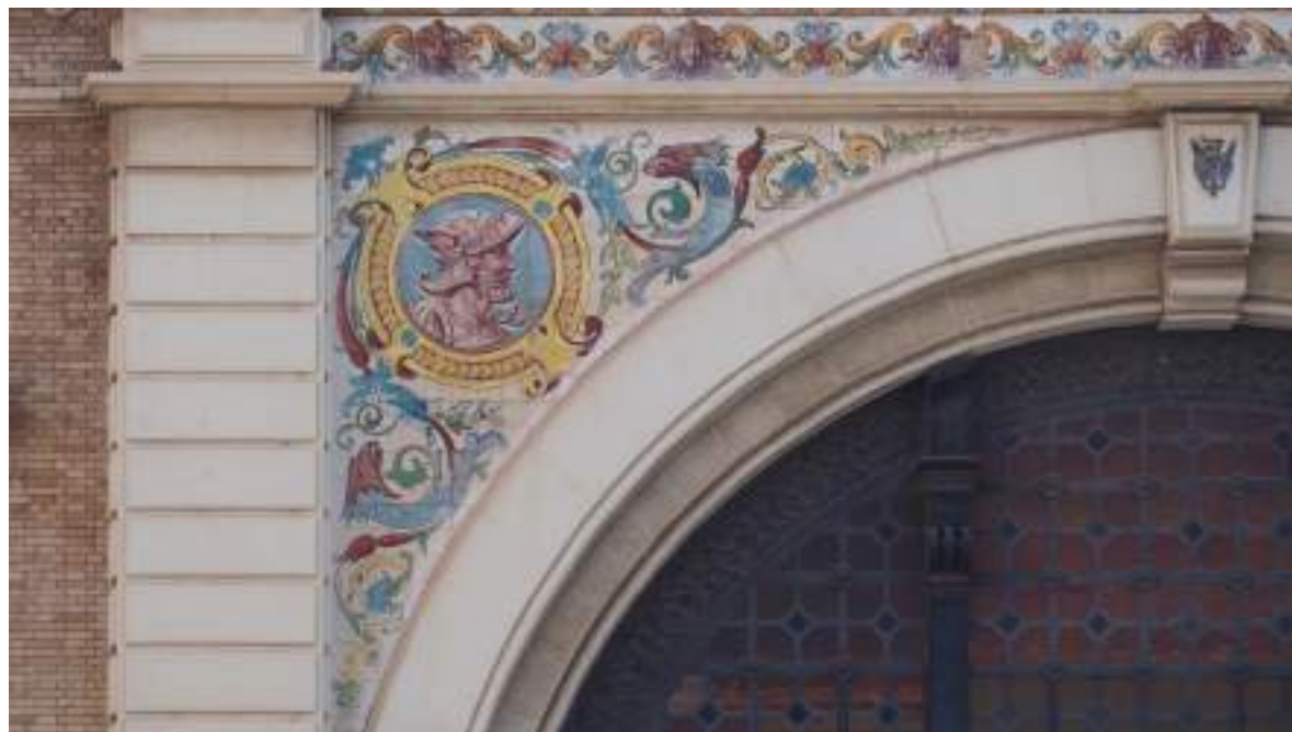
Mural de azulejos en las enjutas del arco de la fachada principal.
