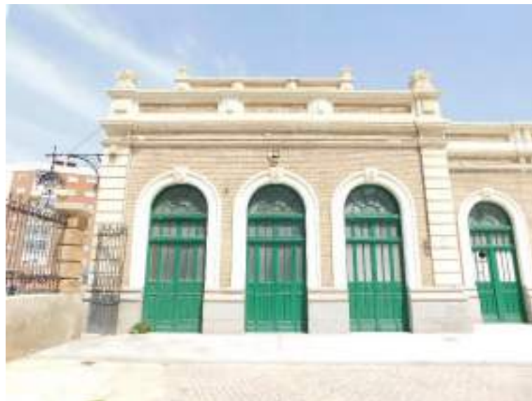
Fachada sur de la nave sur. Esquina suroeste.
