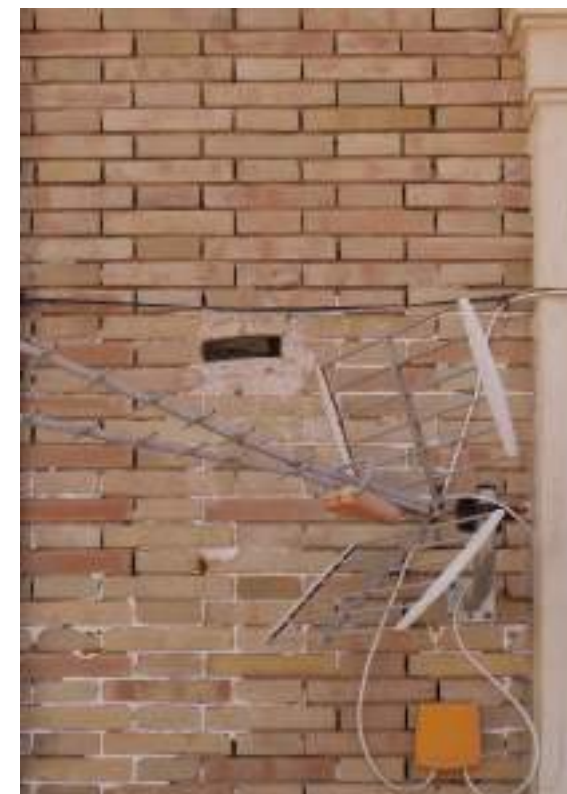
▲ Restos visibles en fachada, silicona, pintura, elementos metálicos y morteros, dejados tras la retirada de antiguos elementos y cartel indicativo moderno.
