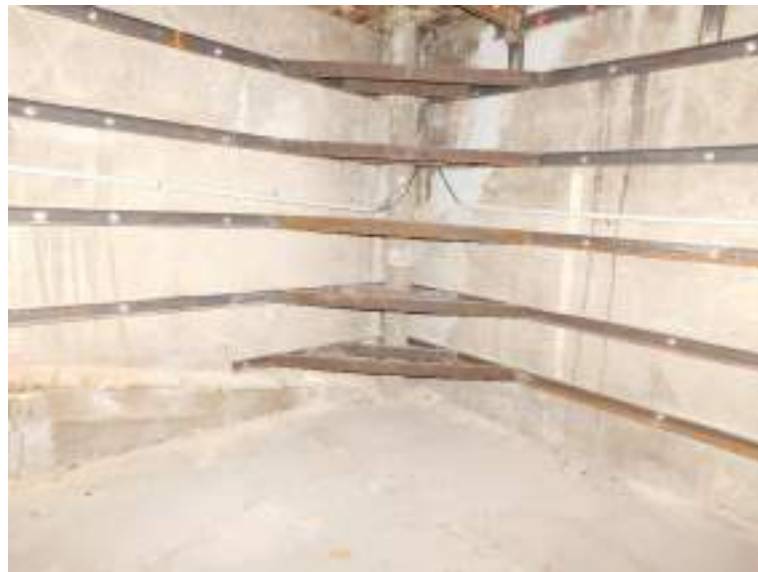
Refuerzos en esquina. Vista desde cámara bajo cubierta.
