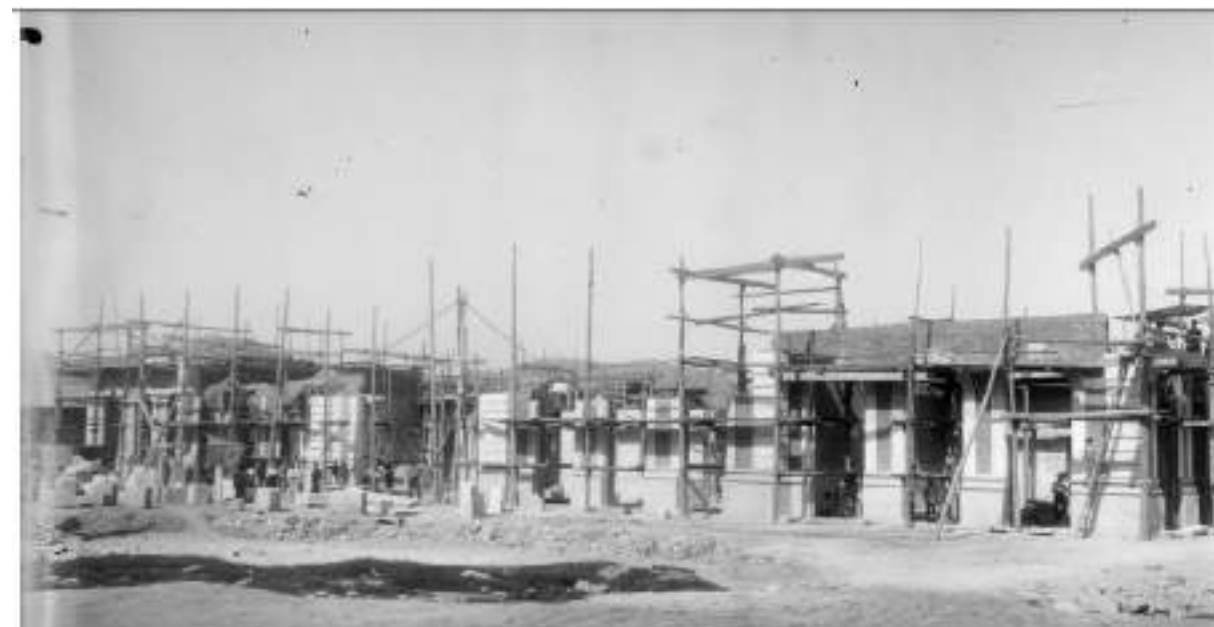
Fig. 46. Imagen que muestra la construcción de ladrillo sobre el zócalo de granito y entre las jambas de las arquerías en construcción de la fachada principal de la Estación Definitiva de Cartagena, AHF-MFM. (Salgado Lancha, J. –fotógrafo). 1905. Estación de Cartagena. [Vista de la estación de Cartagena en fase de construcción. Pertenece a la línea Chinchilla-Cartagena]. Fotografía - Negativo [Vidrio]: bl. y n.; 2729 / 3425 mm. Fondo/Colección MZA - Servicio Vía y Obras. Signatura: MZA- 3437-IF_8-12.
