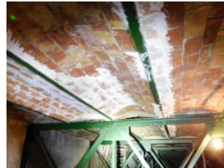
Sustitución de viguetas en forjado de cubierta central
