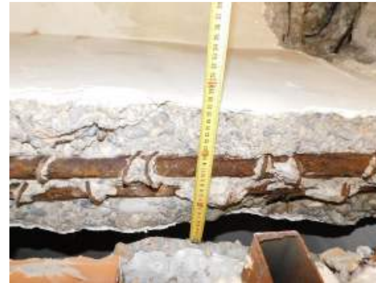
Cata en apoyo de viga de cubierta sureste.
