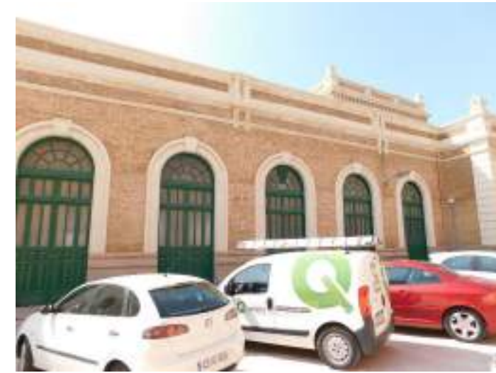
Muro norte. Nave norte.
