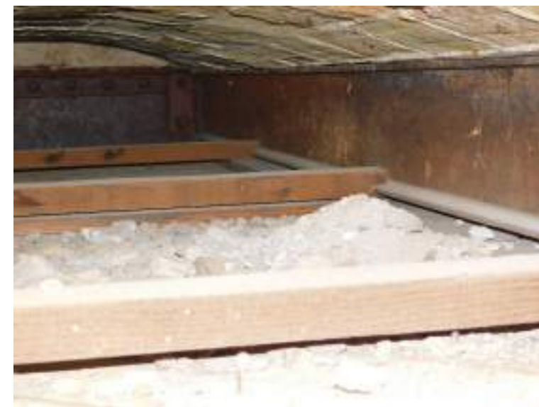
Forjado de planta primera. Vista entre el artesanado y las bovedillas.
