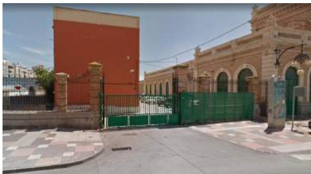
Portón de acceso a aparcamiento zona Norte
