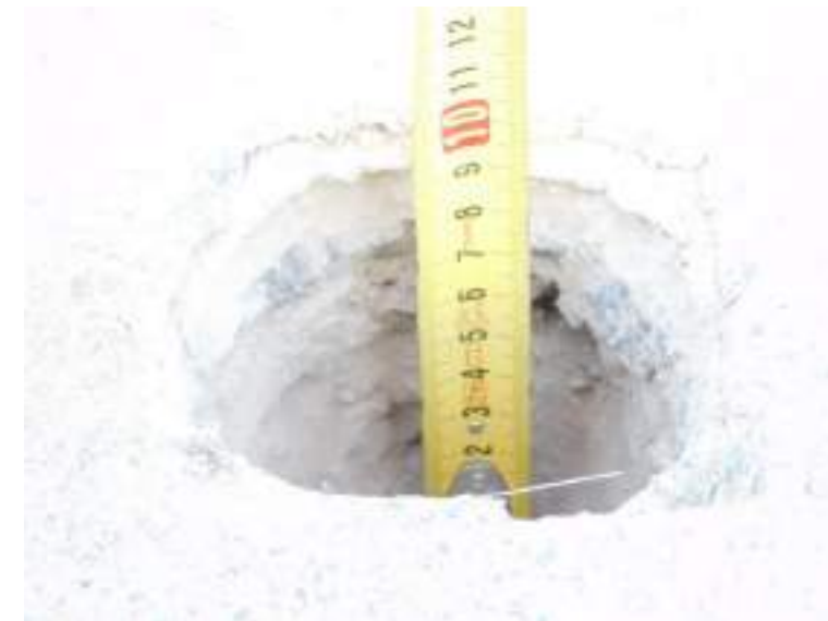
Detalle de cata en cubierta sureste.
