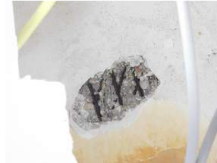
Armadura inferior de la losa de cubierta de la nave norte. Vista inferior.
