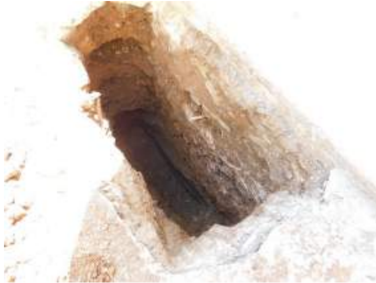
Vista de cimentación en calicata de cuerpo de trabajadores.
