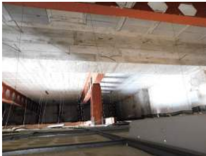
Nuevo forjado de cubierta sobre cafetería. Vista inferior.
