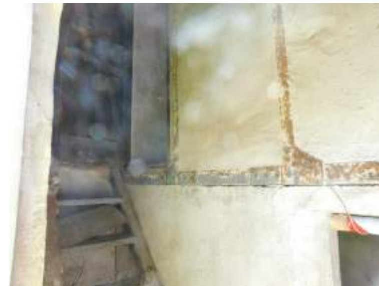
Escalera de acceso a reloj en fachada oeste.
