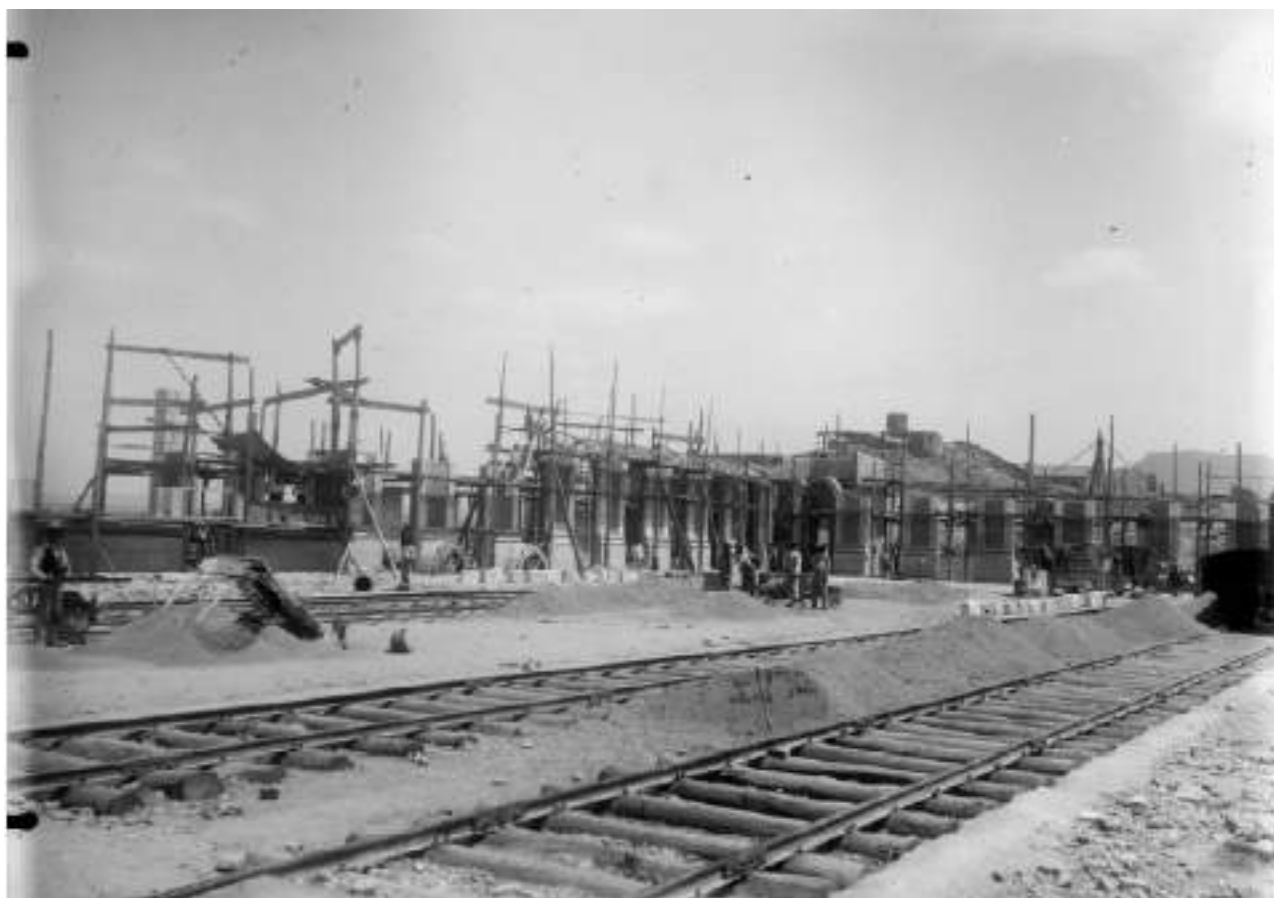
Fig. 47. Imagen que muestra la construcción de ladrillo sobre el zócalo y entre las jambas de las arquerías, con las cimbras para las dovelas dispuestas mientras se alza el muro de ladrillo, AHF-MFM. (Salgado Lancha, J. –fotógrafo). 1905. Estación de Cartagena. [Vista de la estación de Cartagena en fase de
