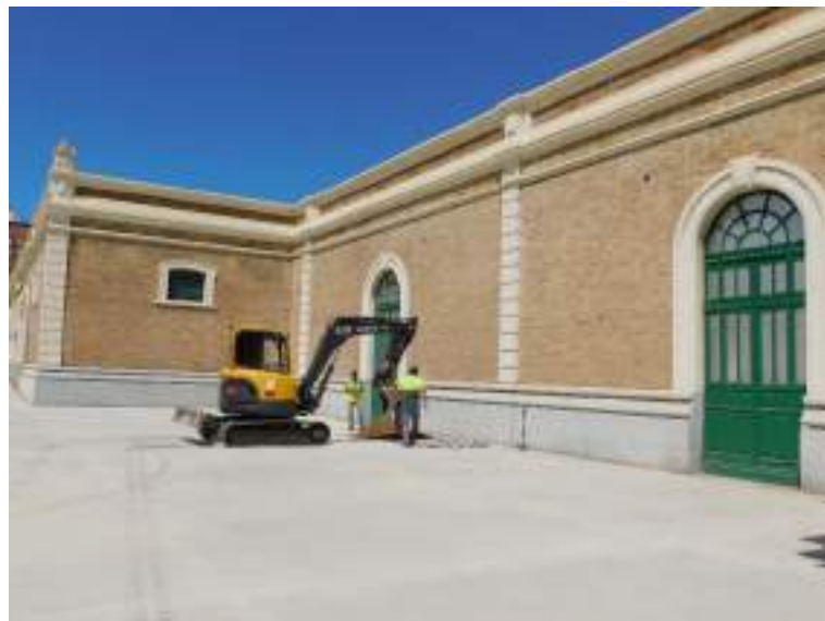
Localización de calicata junto a muro sur.
