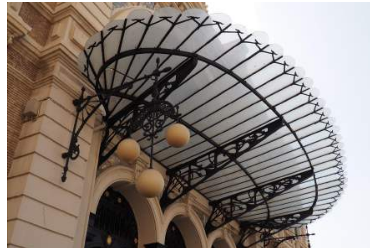
▼ Marquesina de vidrio y hierro en el acceso de la puerta principal al edificio de viajeros.
