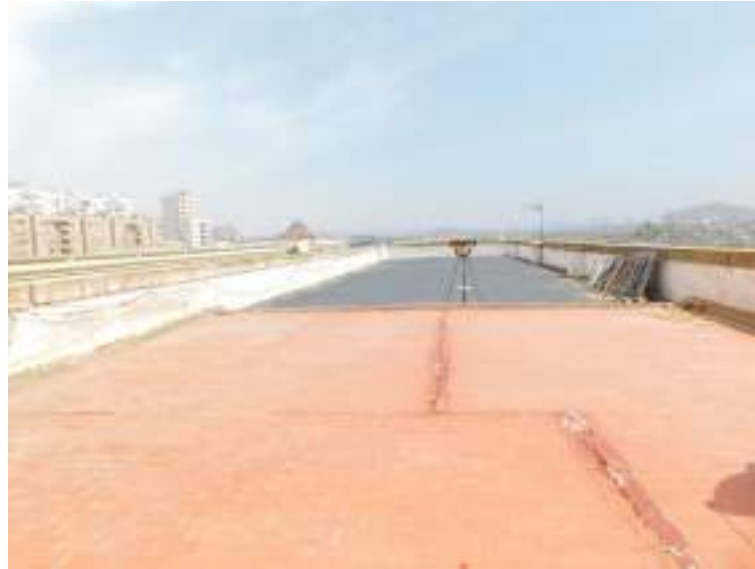
Vista general de la cubierta de la nave sur. Tramo paralelo a vías.
