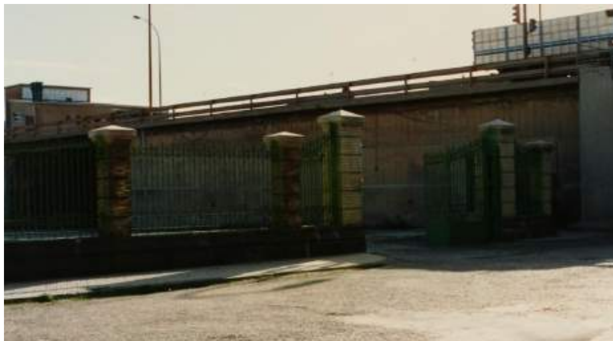
Fig. 103. Fotografía desconocida, Estado de la valla exterior antes de la ejecución del proyecto. (1994). En Rodríguez Senespleda, j. (1994). Proyecto de Recomposición, limpieza y protección de fachada de la Estación de Ferrocarril de Cartagena . AGRM. CARM,3349/2 y SPHRM. Expediente 16.94. Fig. 1 y 3.
