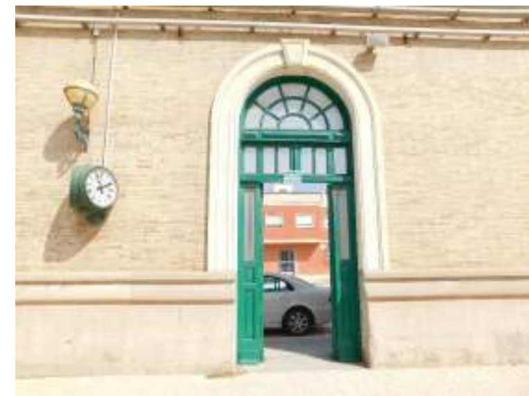
Hueco tipo en muro exento junto al andén norte. Vista frontal.
