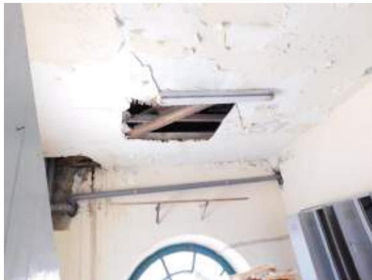
Falso techo de cañizo. Vista interior.
