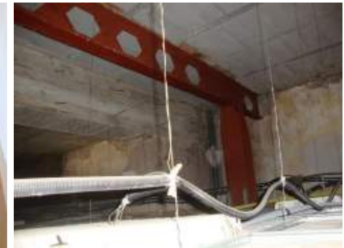
Estructura cubierta y falso techo
