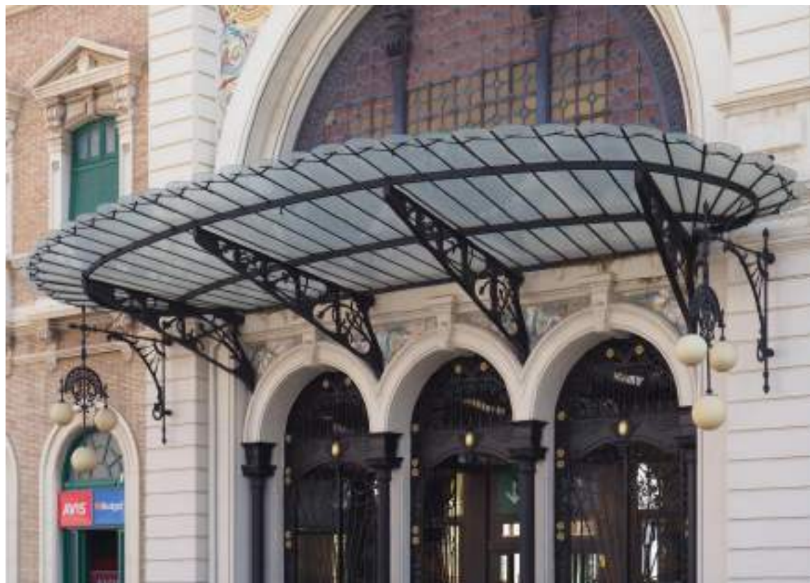
Vista de las carpinterías metálicas en el acceso al edificio de viajeros.
