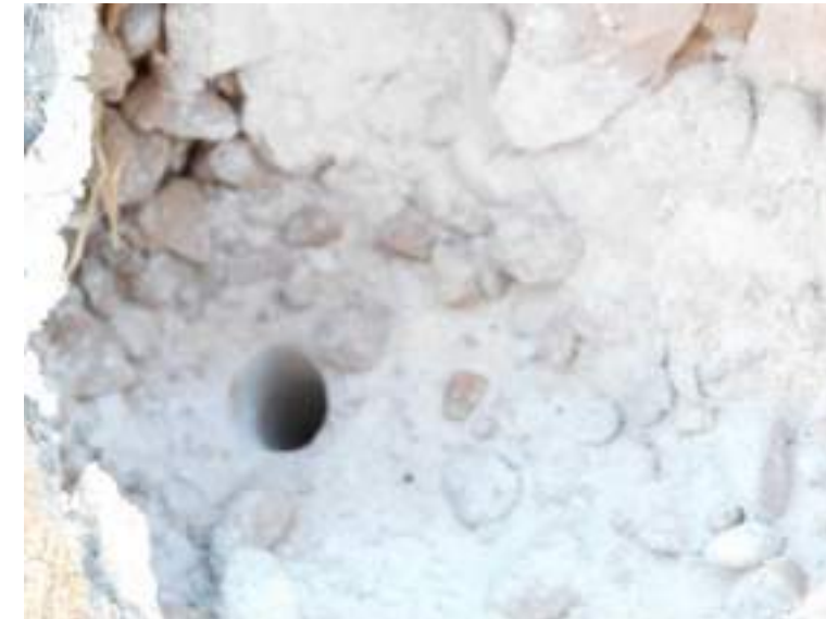
Taladro en forjado de cubierta suroeste.
