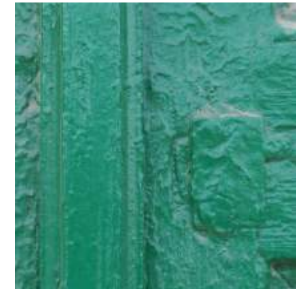
▲ Aspecto irregular de una carpintería por la falta de preparación de la superficie antes de ser pintada.
