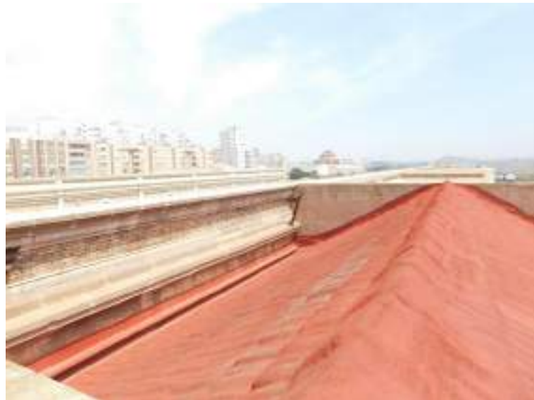
Cubierta a dos aguas de la ampliación de nave sur.
