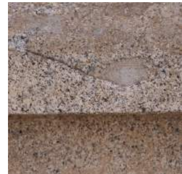
▲ Pequeña reintegración en piedra caliza con cemento. Las diferencias de dilatación de los materiales pueden facilitar la apertura de fisuras y grietas, llegando a agravar los daños en el material.
