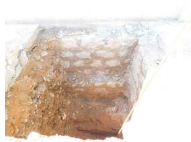
Detalle de cimentación de muro exento sur.
