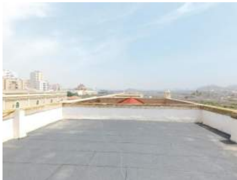
Peto de separación entre la nave sur original y la ampliación.
