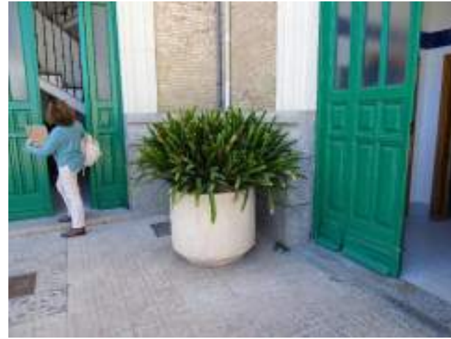
Acceso a viviendas y aseos
