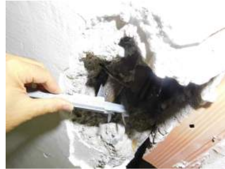
Detalle de cata en centro de vano de viga de cubierta en cuerpo sur
