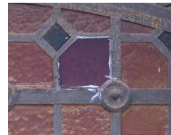
▲ Detalle de una pieza de vidrio sustituida por otra de vidrio simple coloreado, dejando restos de la masilla empleada para la instalación de la pieza.
