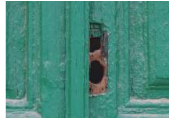
▲ Detalle de una carpintería que no conserva los herrajes originales.
