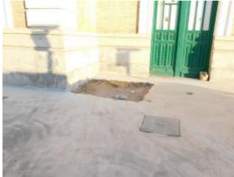
Localización de calicata en retranqueo de fachada sur.
