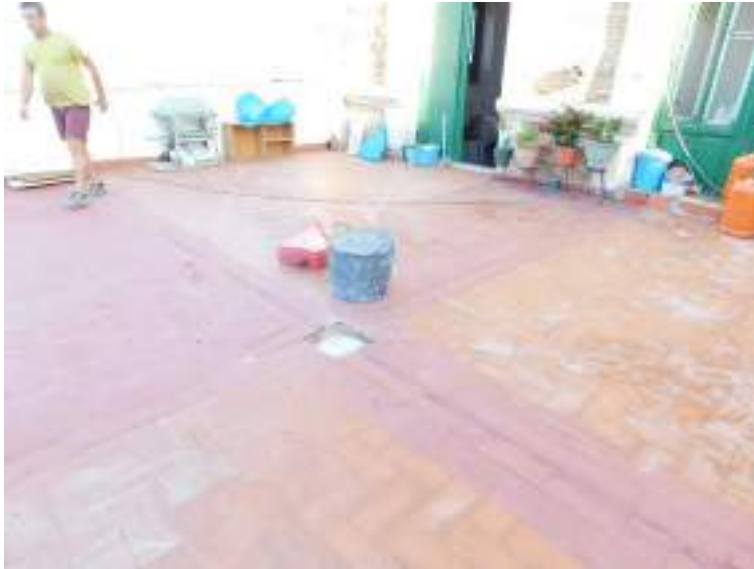
Localización de cata en cumbrera de cubierta noroeste.
