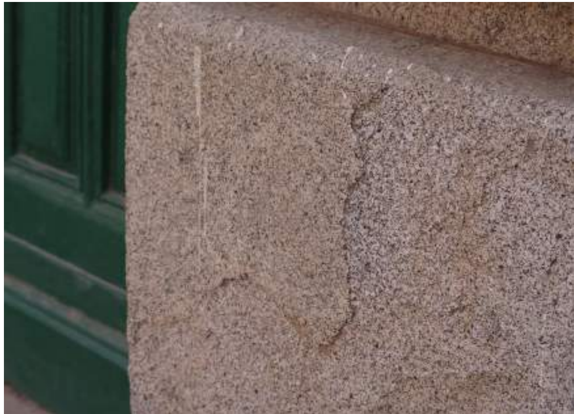
▲ Detalle de una importante deplacación en el zócalo de granito.
