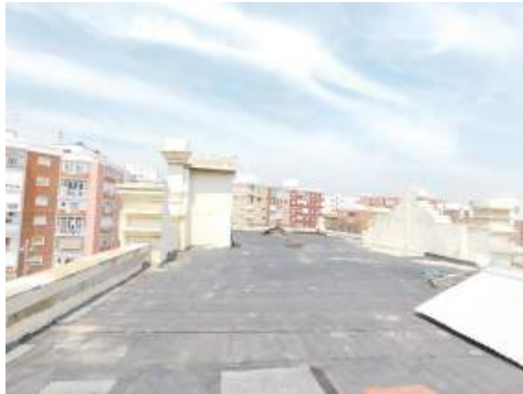
Vista general de la cubierta de la nave central.
