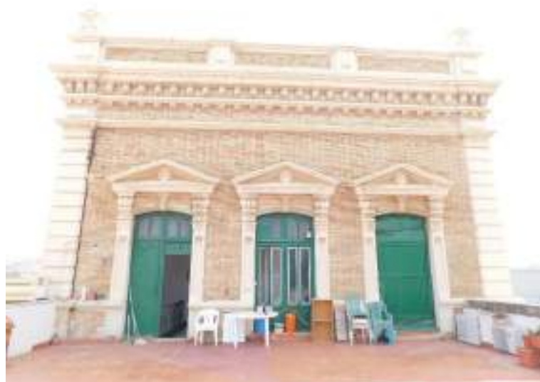
Fachada norte en planta segunda. Nave central de acceso.
