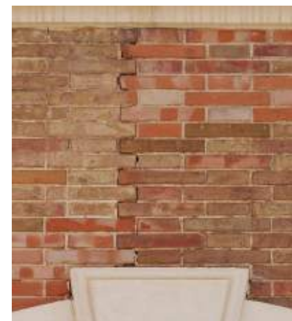
▲ Importante grieta de recorrido escalonado en uno de los paños de fachada.
