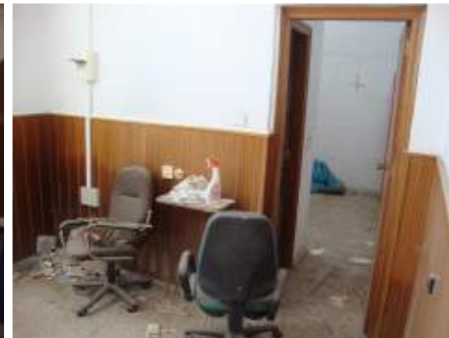
Despacho en desuso
