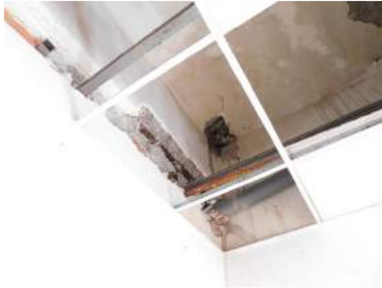
Localización de catas en apoyo de viga y losa de cubierta sureste.
