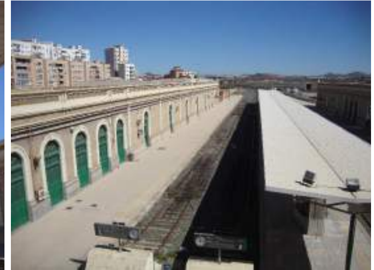
Andén Norte y vías
