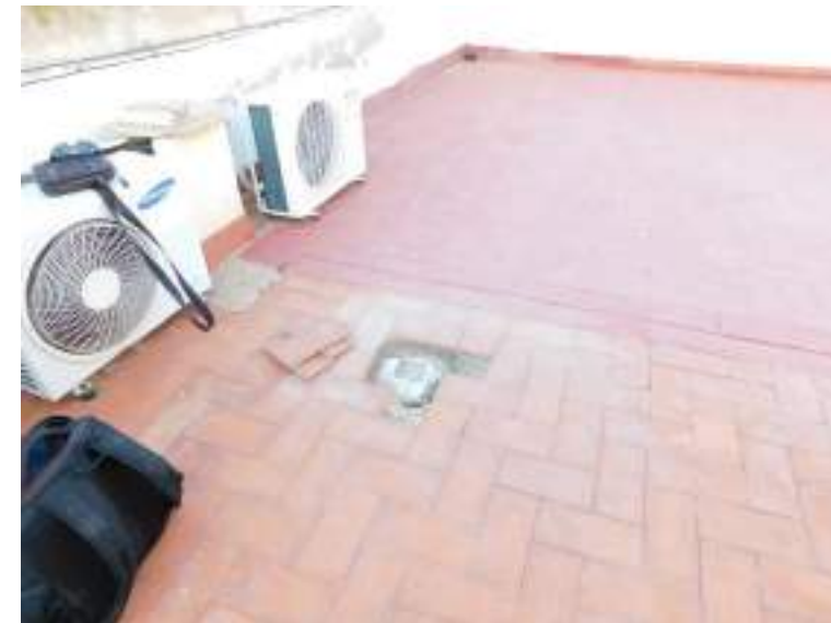
Cata en cubierta noroeste.
