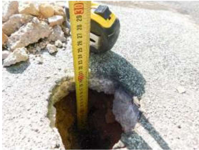
Detalle de cubierta en cuerpo central
