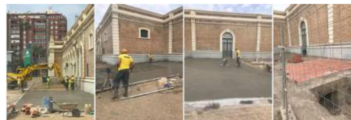
Fig. 116. MOFI. Montajes e instalaciones S.L. Estación de Cartagena, 2019. Recuperado en https://www.flickr.com/photos/163665095@N03/albums/72157675963972287
