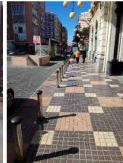
Adoquinado entrada estación
