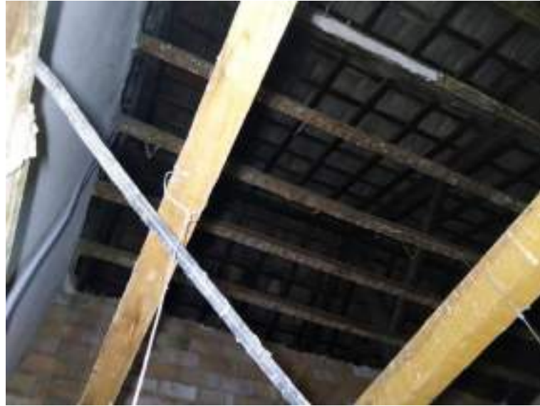
Cubierta cuerpo sur añadido.
