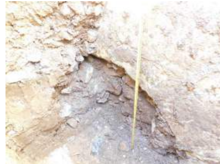
Fondo de excavación de hastial sur del cuerpo central.
