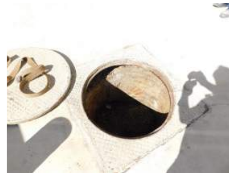
Registro junto a calicata en esquina suroeste de cuerpo central.
