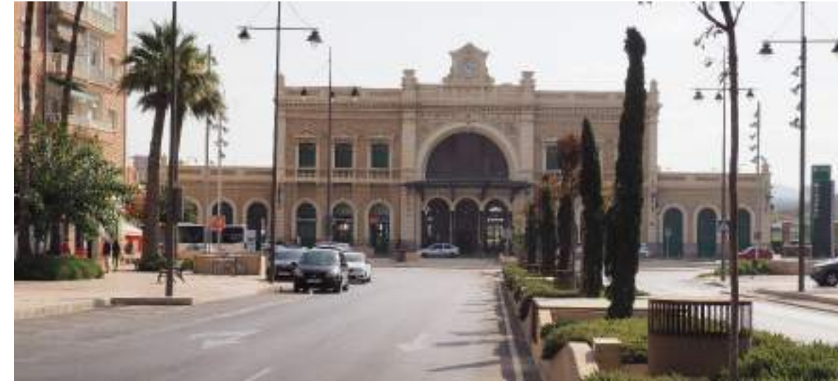
Vista general del edificio de viajeros de la estación de Cartagena.
