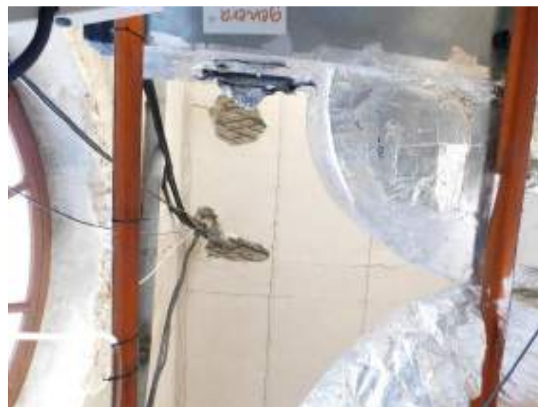
Cara inferior de estructura de cubierta noroeste.
