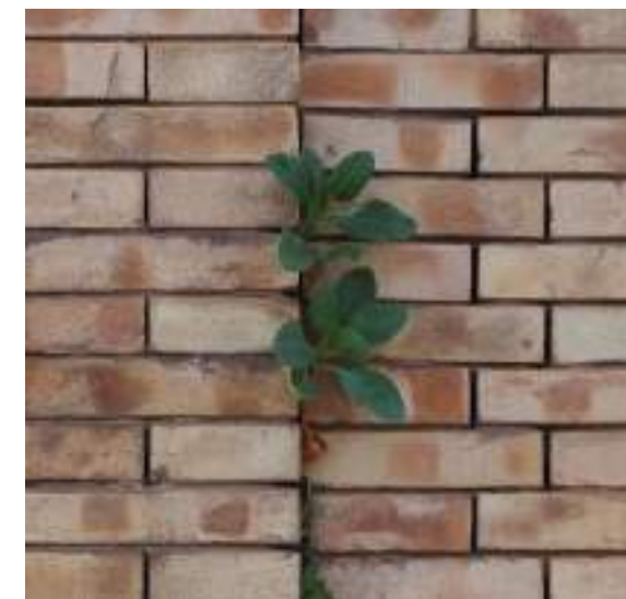
▲ Detalle una planta superior que se ha desarrollado en la junta entre dos paños de la fábrica de ladrillo.
