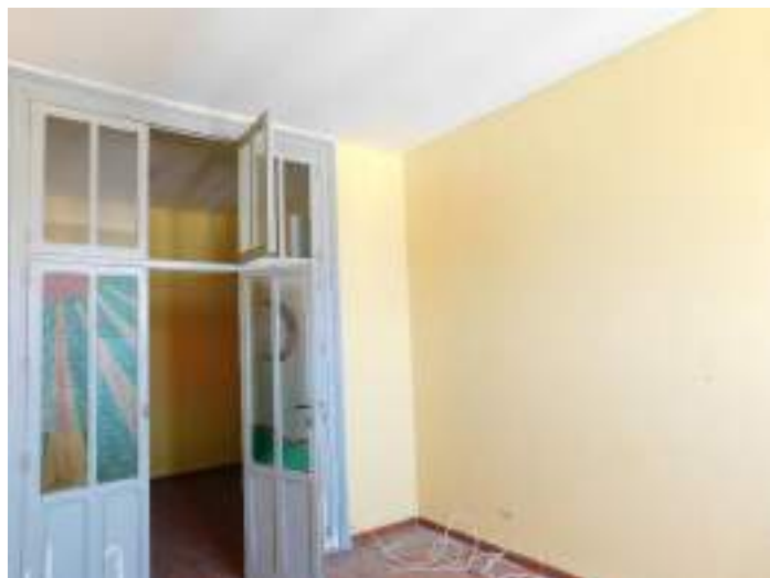
Zona interior de la vivienda de planta primera.
