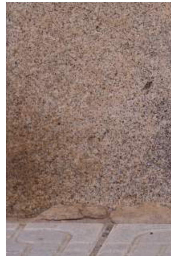
▲ Pequeña reintegración en piedra caliza con cemento. Las diferencias de dilatación de los materiales pueden facilitar la apertura de fisuras y grietas, llegando a agravar los daños en el material.
