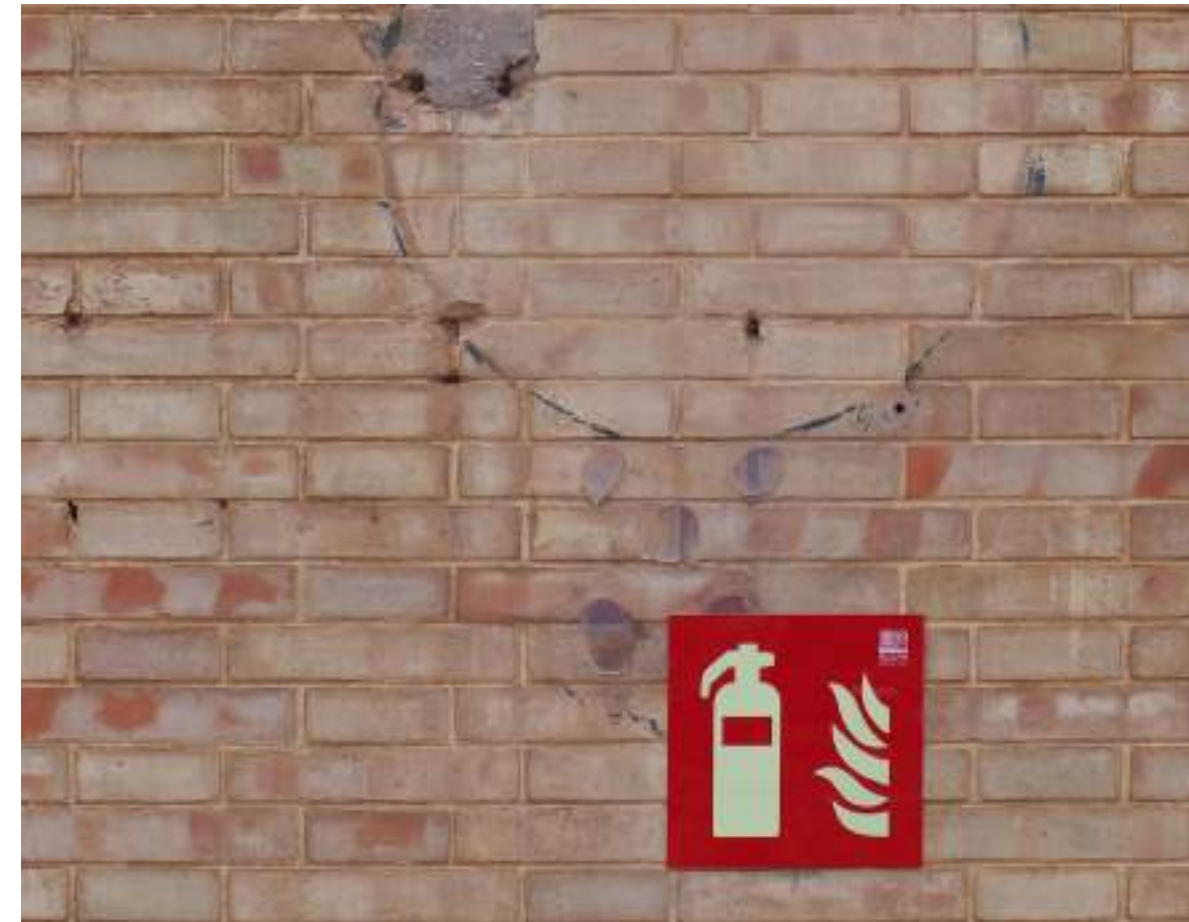
▲ Restos visibles en fachada, silicona, pintura, elementos metálicos y morteros, dejados tras la retirada de antiguos elementos y cartel indicativo moderno.
