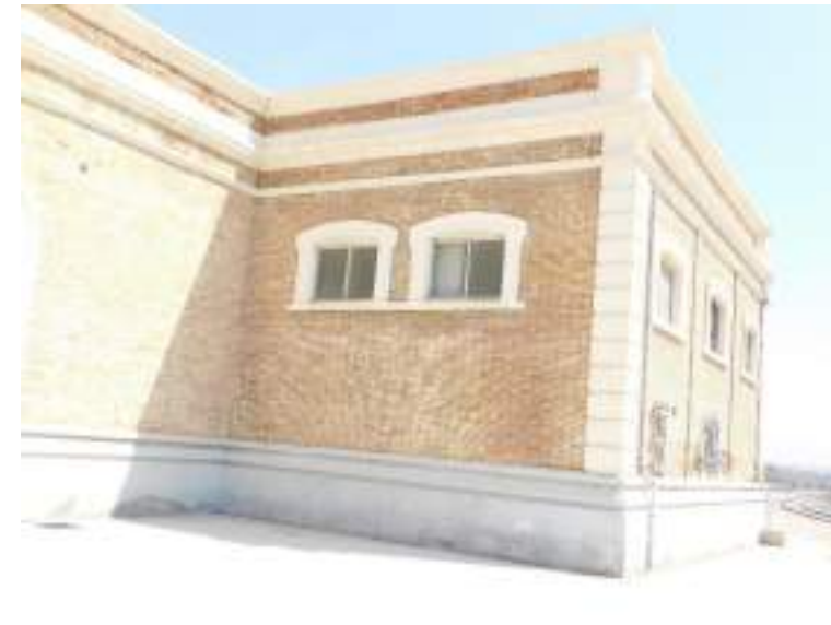
Fachada oeste del edificio de trabajadores.
