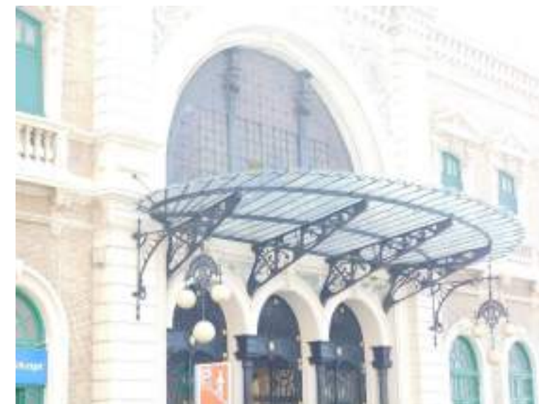
Marquesina. Nave central de acceso.
