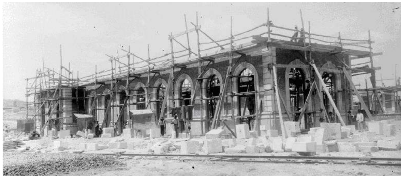
Fig. 44. Fotografía que muestra los sillares de cantería de granito y la caliza de Cieza, éstos de menor tamaño, a pie de obra en uno de los pabellones laterales (posiblemente el pabellón sur-salidas) antes de la realización de la cubierta. AHF-MFM. (Salgado Lancha, J –fotógrafo-) (ca. 1906). Estación de Cartagena. [Vista de la estación de Cartagena en fase de construcción. Pertenece a la línea Chinchilla-Cartagena]. 1 Fotografía - Negativo [Vidrio]: bl. y n.; 2780 / 3425 mm. Fondo/Colección MZA - Servicio Vía y Obras. Signatura: MZA- 3436-IF_8-12-.
