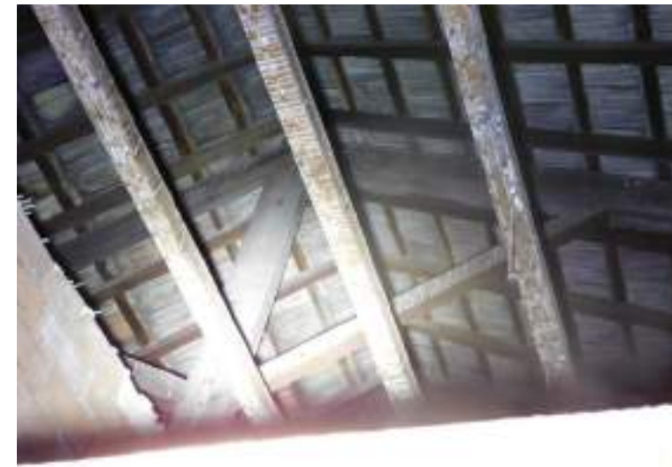
Cercha de cubierta de madera sobre cuerpo sur añadido.
