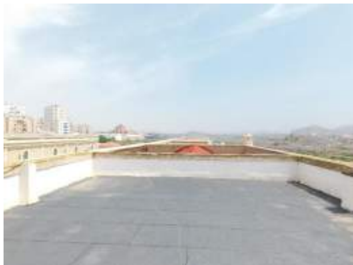
Láminas impermeabilizantes a la vista.
