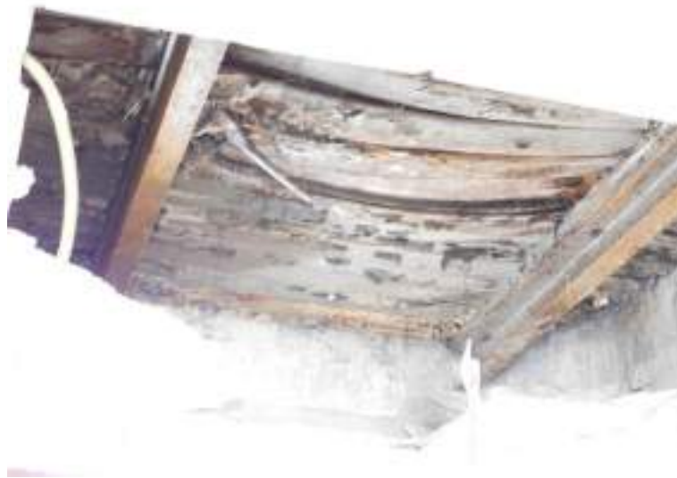
Forjado de planta primera con viguetas metálicas. Vista inferior.
