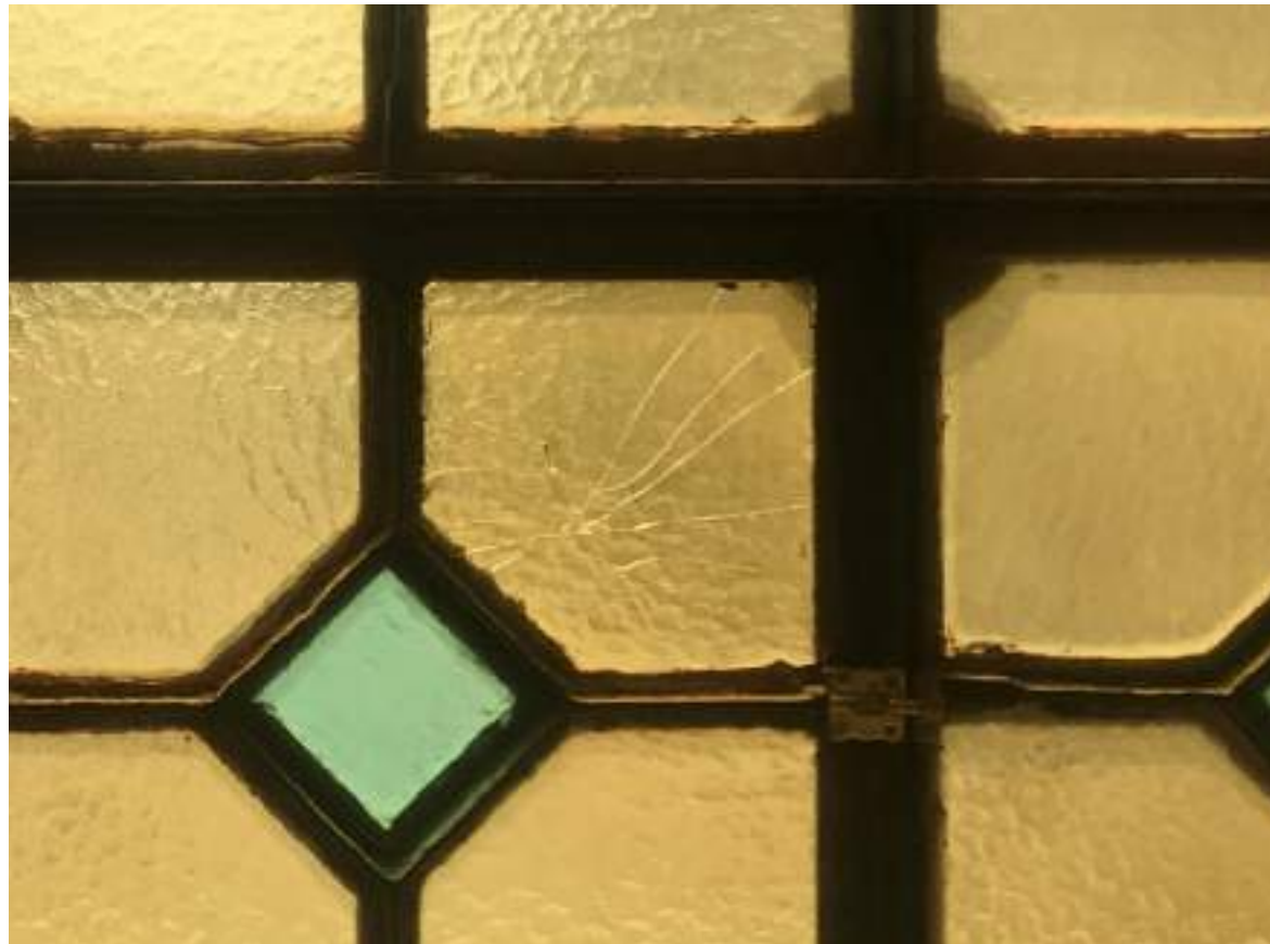
▲ Detalle de la rotura de una de las piezas de la vidriera.
