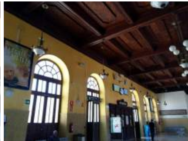
Acceso a andenes
