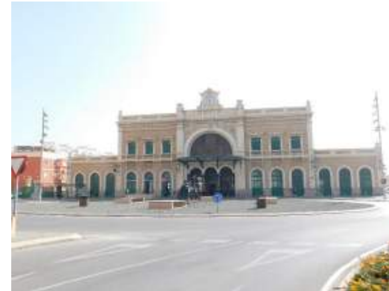
Fachada oeste. Nave central de acceso.
