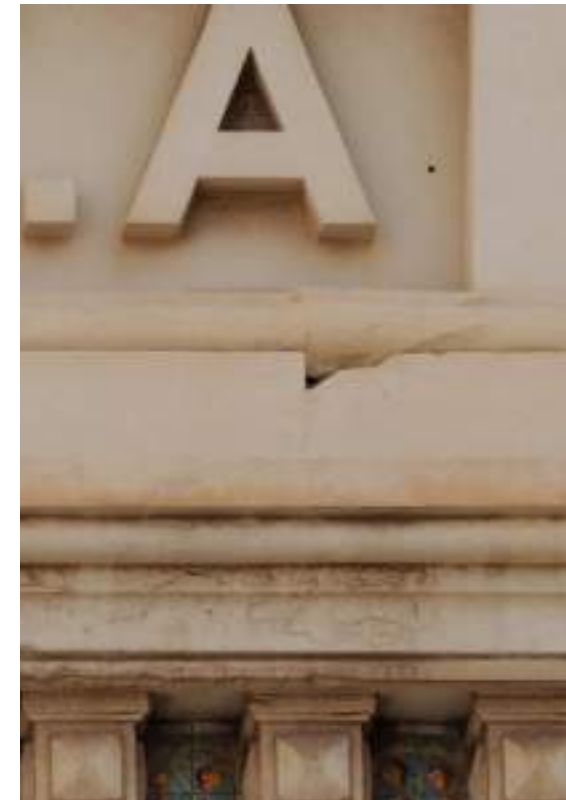
▼ Fisuras en elementos decorativos de piedra artificial.
