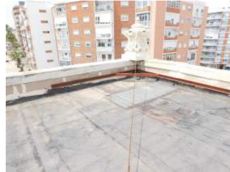
Refuerzo en esquina y cable de sujeción para los pináculos.
