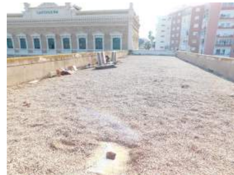
Localización de cata en cubierta noreste.
