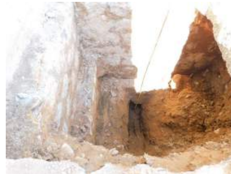
Detalle de fondo de calicata en muro exento sur.
