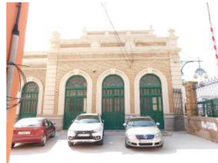
Fachada norte de la nave norte. Esquina.
