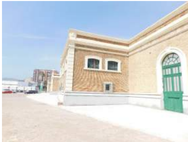
Fachada este del edificio de trabajadores.
