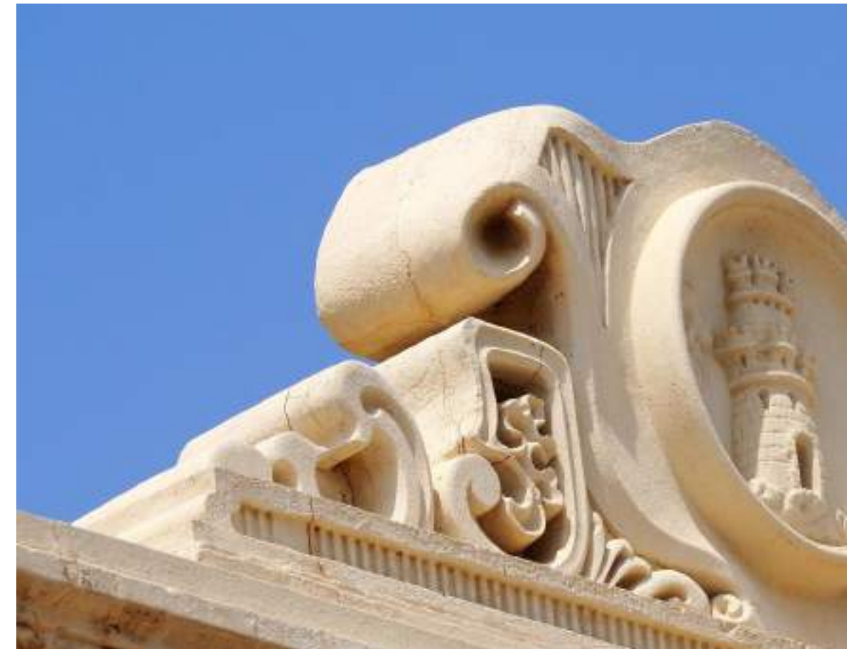
▼ Fisuras en elementos decorativos de piedra artificial.
