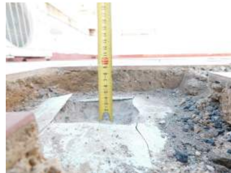
Detalle de cata en cubierta noroeste.
