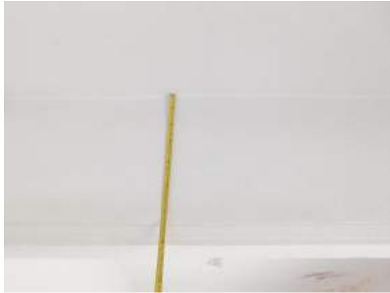
Canto de la viga de descuelgue. Nave norte.
