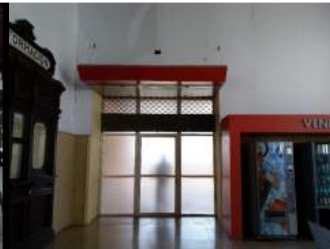
Zona de vending y acceso a cafetería en desuso
