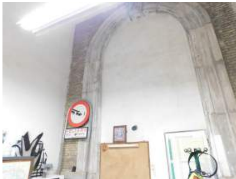
Muro testero original de la nave sur. Vista interior desde la zona ampliada.
