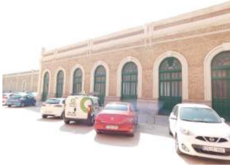
Fachada norte de la nave norte. Vista general.
