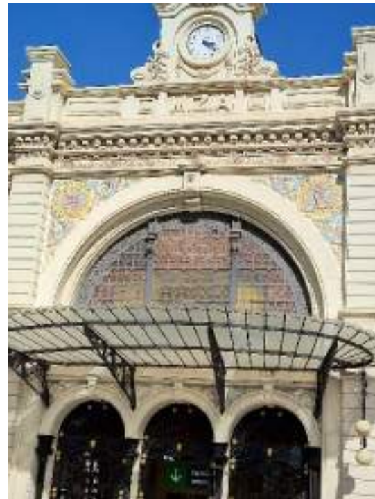
Acceso en fachada principal
