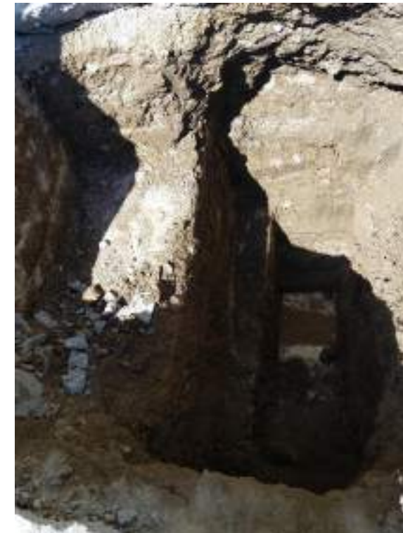
Calicata junto a la esquina sureste de la cafetería
