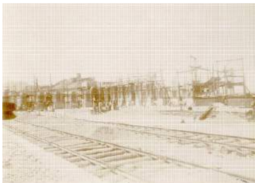
Fondo / Colección: M.Z.A. - Servicio Vía y Obras. Signatura: F- 0166- Copias: Diapositiva Volumen: 1 Fotografía (s) - Positivo [Papel] : Sepia ; 285 x 230 mm ; presentación: 390 x 330 mm Fecha: 09/08/1905 Autor: LE BRET , EMILIO (FOTÓGRAFO) Título: Obras en la estación definitiva de Cartagena en la línea de Albacete a Cartagena Descripción: Vista de las obras en una esquina del edificio de viajeros de la estación. Aparece personal de obras posando.
