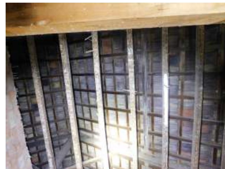
Faldón sur de cubierta sobre cuerpo sur añadido.
