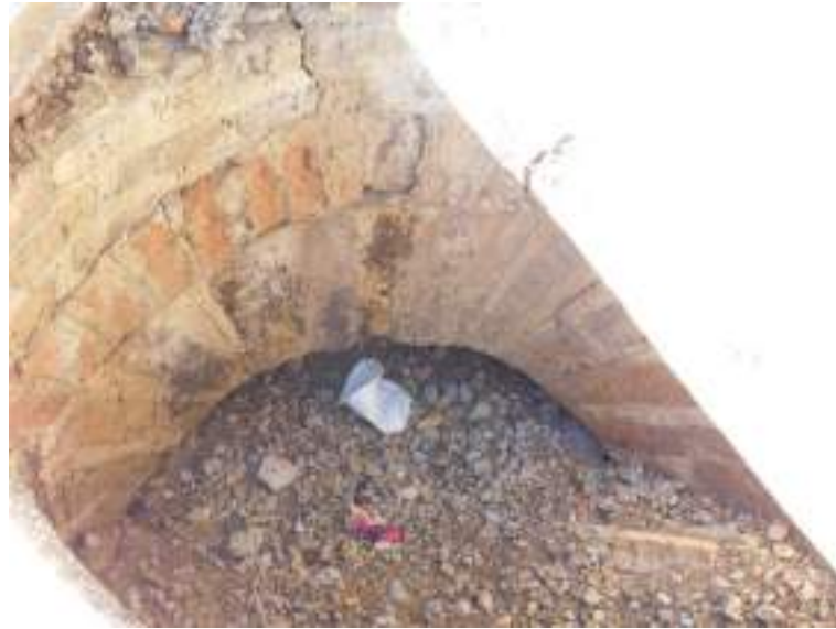
Detalle de galería colmatada en registro.
