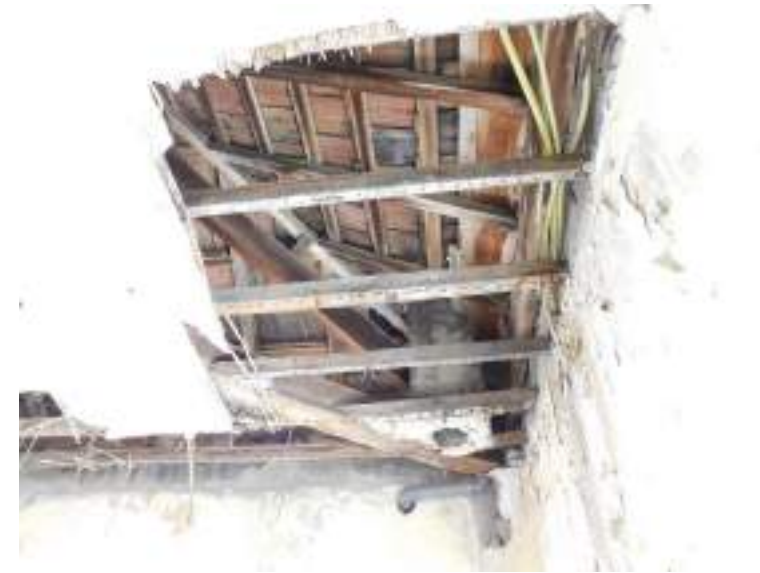
Cubierta con estructura de madera. Vista inferior.
