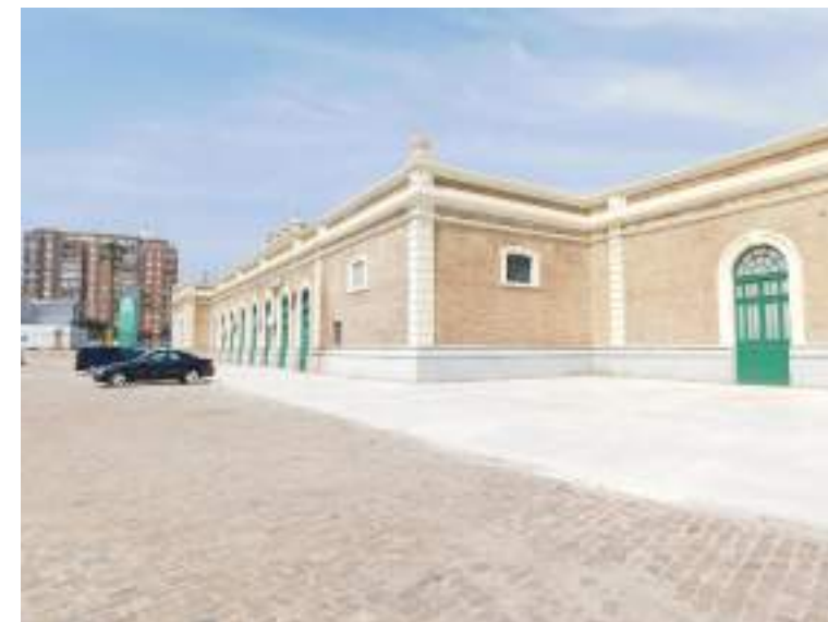
Ampliación de la nave sur.
