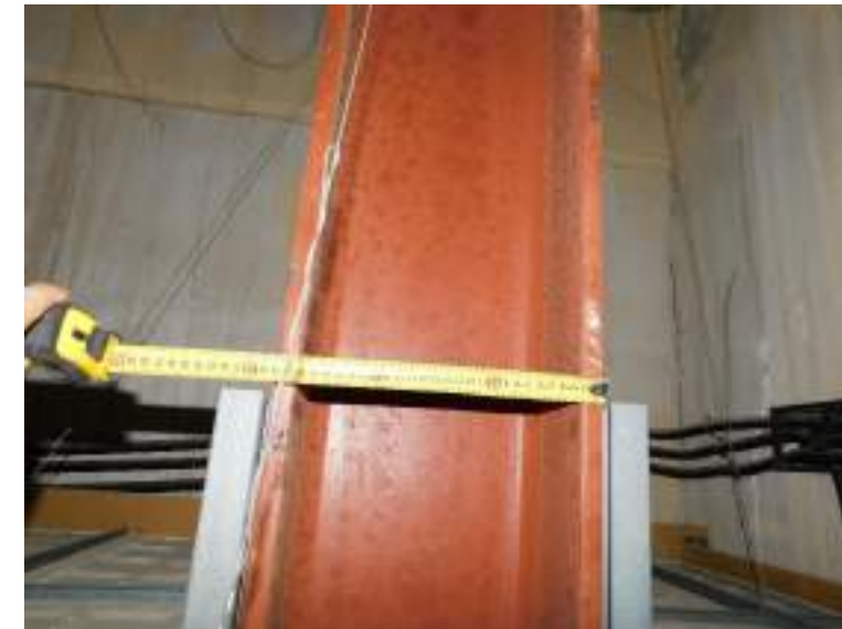
Detalle de los soportes metálicos.
