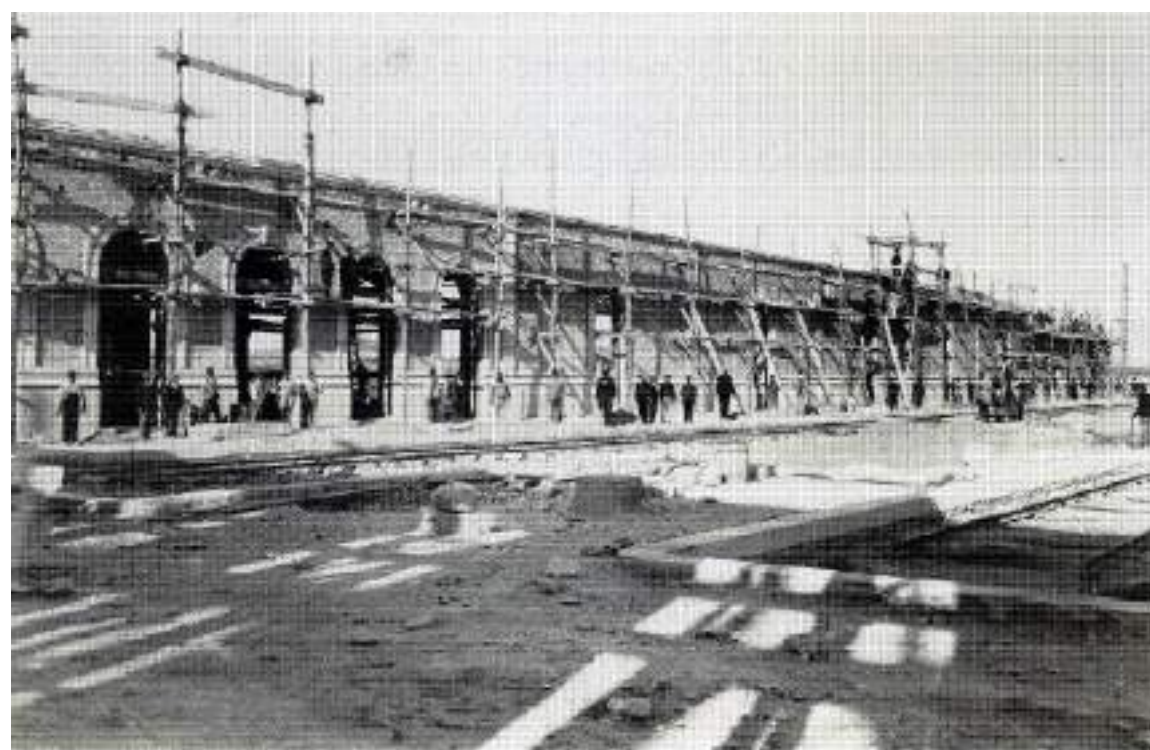
Fig. 41. Imagen de la construcción del pabellón y muro de cierre lateral junto al andén de Llegadas durante las labores de colocación de la cornisa de cemento a medida que avanzan las arquerías de piedra y los muros de ladrillo fino. AHF-MFM. (Salgado Lancha, J –fotógrafo-), 8 de febrero de 1906. Estación definitiva de Cartagena, de la línea de Chinchilla a Cartagena de la Compañía MZA. Fotografía - Positivo [Papel]: bl. y n.; 230 x 290 mm; presentación: 330 x 410 mm. Fondo/Colección MZA - Servicio Vía y Obras. Signatura: F- 0205.
