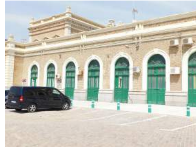
Fachada sur de la nave sur. Vista general.
