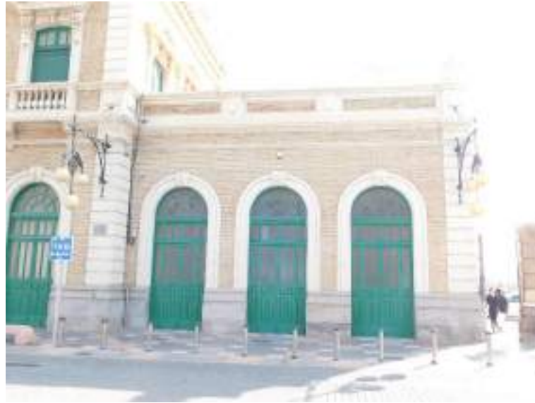
Fachada oeste de la nave sur.
