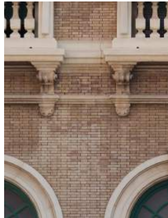
▲ Eflorescencias salinas en la fábrica de ladrillo, coincidiendo con una zona con rejuntado de cemento.
