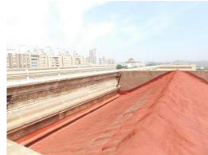
Cubierta de la zona de ampliación.
