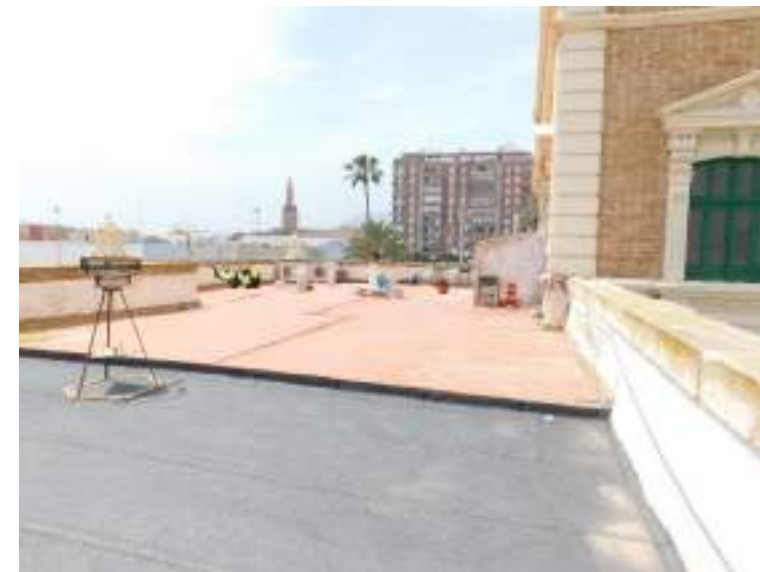
Vista general de la cubierta de la nave sur. Esquina suroeste.
