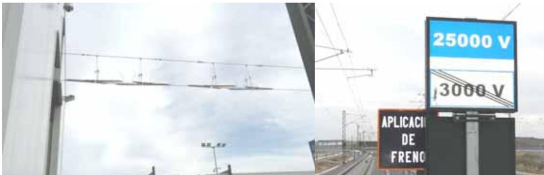
A la izquierda, seccionadores aéreos a la entrada del cambiador. A la derecha, la señal muestra que cambia la tensión de electrificación
