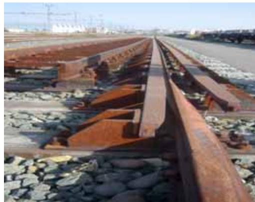
Cambiador para tecnologías Rafia y SUV-2000 instalado en Irún para pruebas
