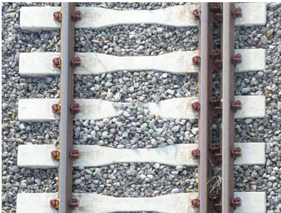
En la vía de tres carriles se puede apreciar la diferencia entre el ancho estándar (1.435mm) y el ibérico (1.668mm). La foto está tomada en Pozal de Gallinas, en el tramo de ensayos de Olmedo a Medina del Campo
