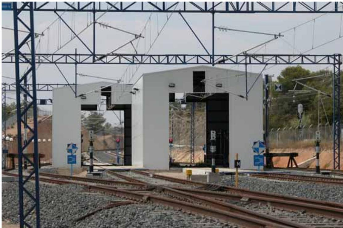
En Roda de Bará (en la foto) y en Antequera, los cambiadores son dobles, lo que permita cambiar el ancho simultáneamente a los trenes que circulan en sentido contrario
