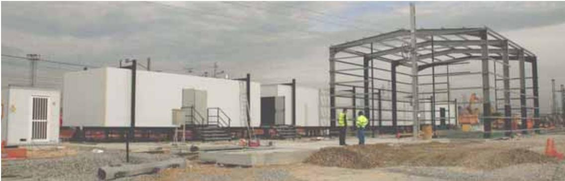
Junto a los cambiadores de tercera generación se construyen módulos trasladables en los que se ubican los equipos auxiliares
