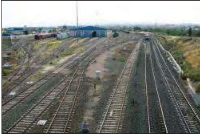
Vista hacia Alcantarilla de la estación de Murcia Cargas, en Nonduermas
